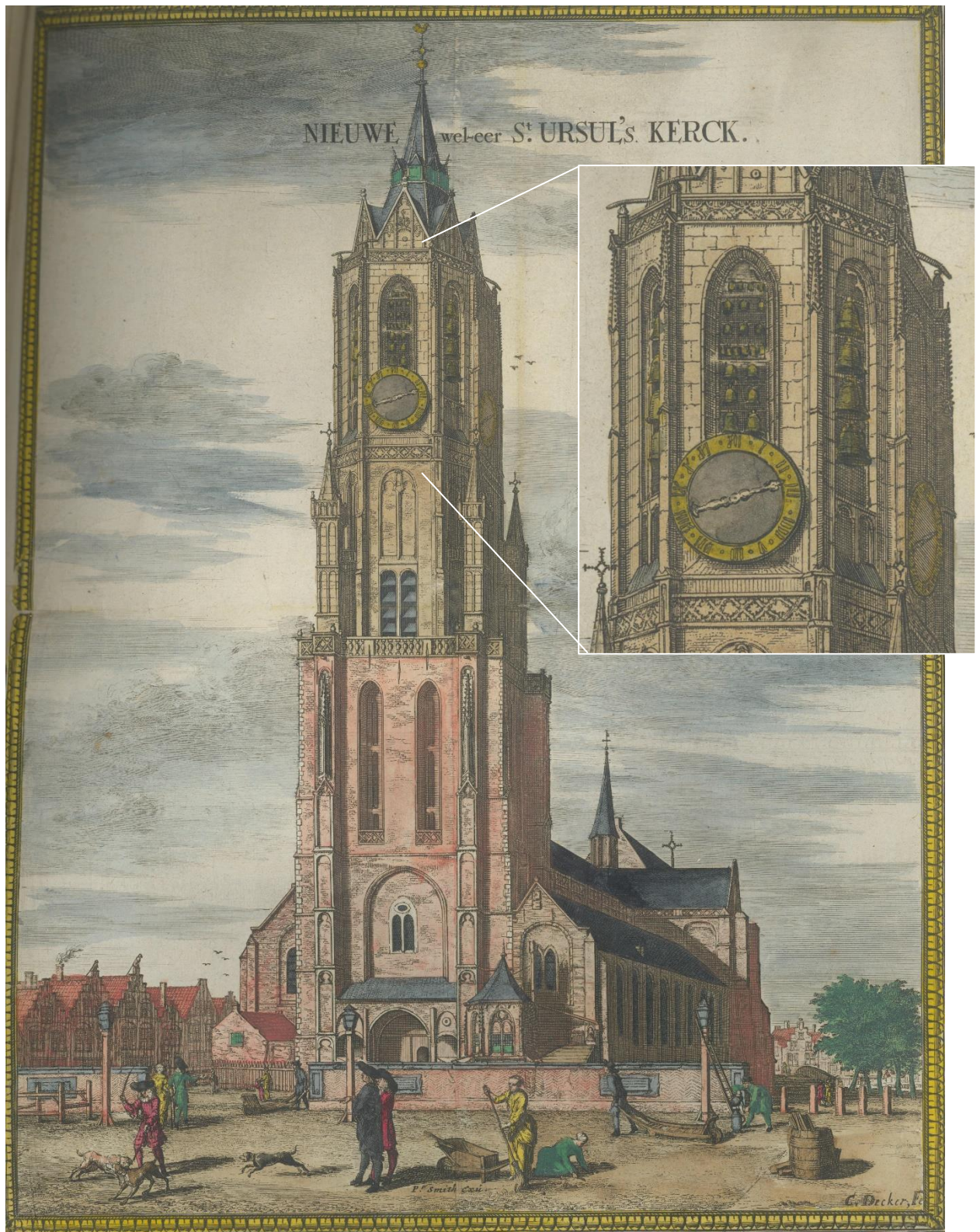
Afb. Coenraet Decker, Nieuwe Kerk aan de Markt met recent aangebrachte wijzerplaten en carillon klokken in de vensters van het bovenste achtkant. De grote blokformaten aan de West, Noordwest en Zuidwestzijde van het achtkant wijzen op de forse zandsteenformaten, ca. 1680, bron: Beeldbank Stadsarchief Delft, objectnummer 71700.
