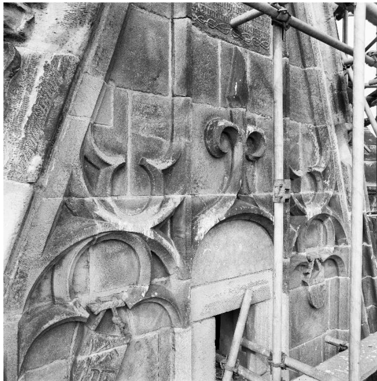
Afb. G.J. Dukker, Restauratie van het bovenste achtkant, een van de grote zandstenen wimbergen, oktober 1984, bron: Beeldbank RCE, nr. 254.795
