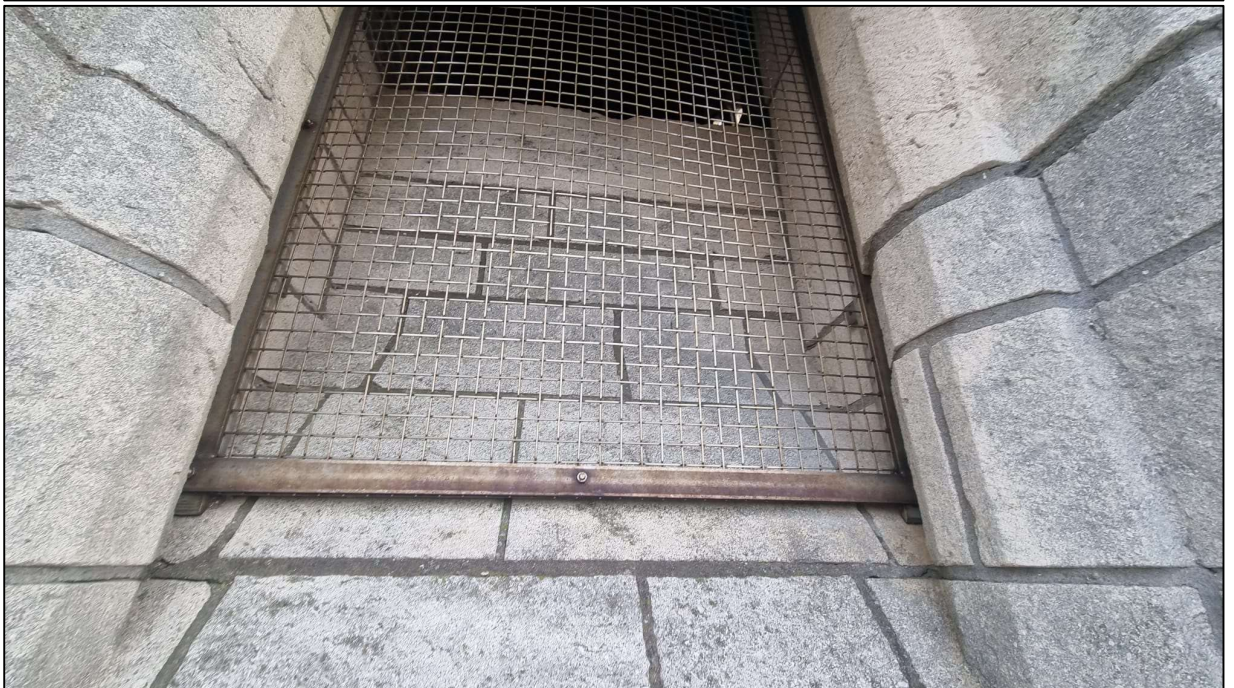
Figuur 2.5. De toren is veelal dichtgezet met gaas en de muren zijn veelal glad, goed onderhouden en zonder kieren of gaten.
