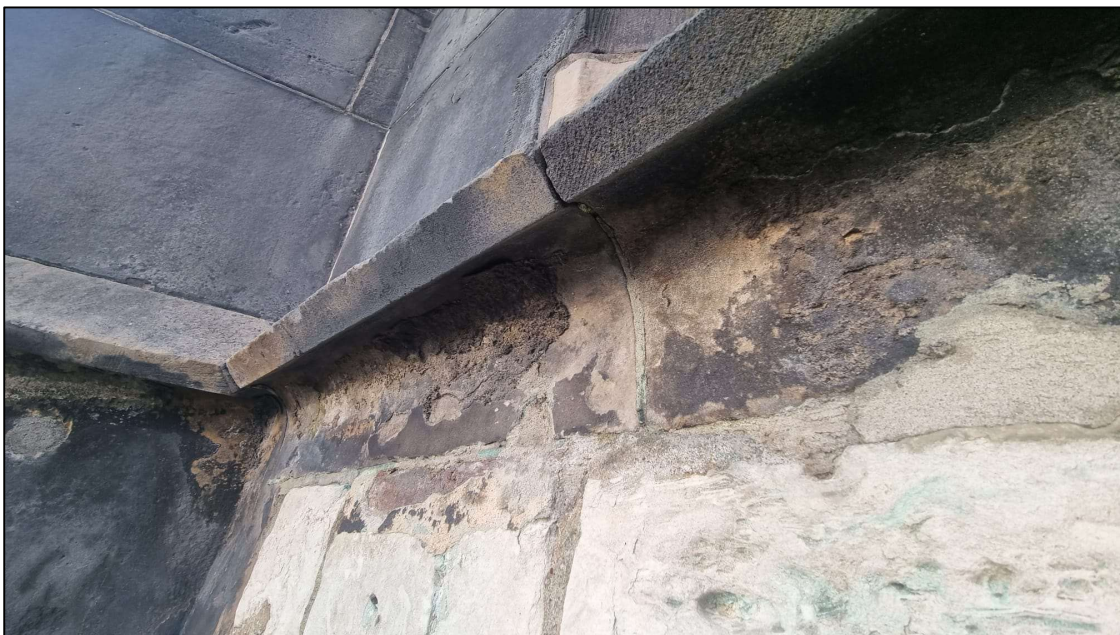
Figuur 2.3. Randen en voegen op de toren zijn goed onderhouden en bevatten geen geschikte ruimtes voor nesten.
