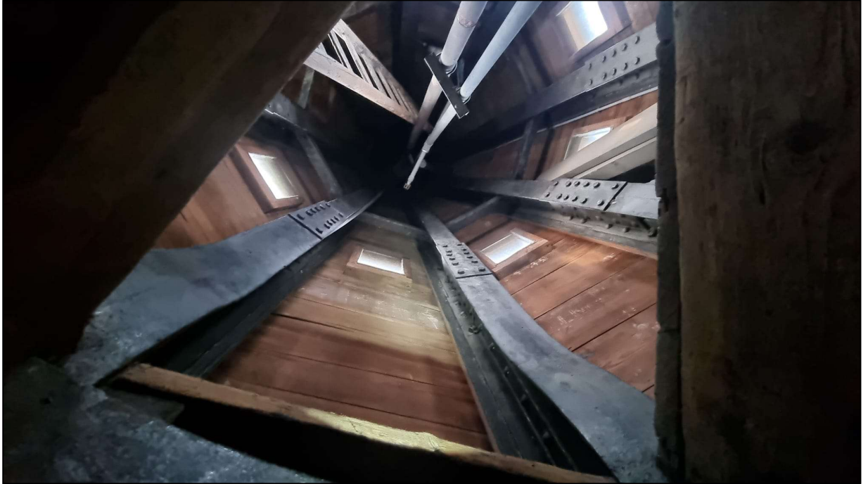
Figuur 2.6. Nok van de toren is opgebouwd uit metalen balken.
