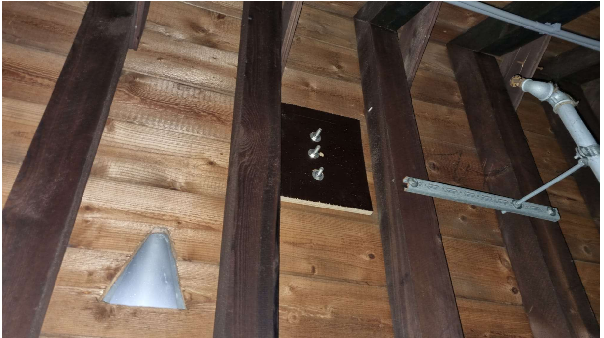
Figuur 2.4. Luik dichtgemaakt om toegang van vogels te ontnemen.
