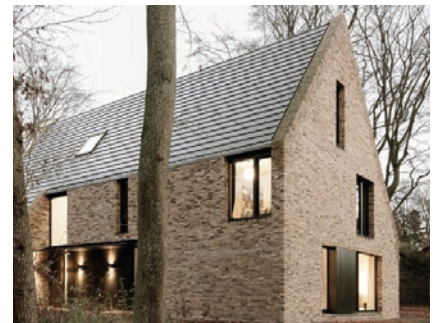
Afb. 2.22 - geleding met grote vlakken en diepe negge
