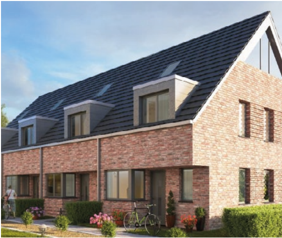
Afb. 3.21 - zadeldak langskap, dakkapelen en gevelverspringing
