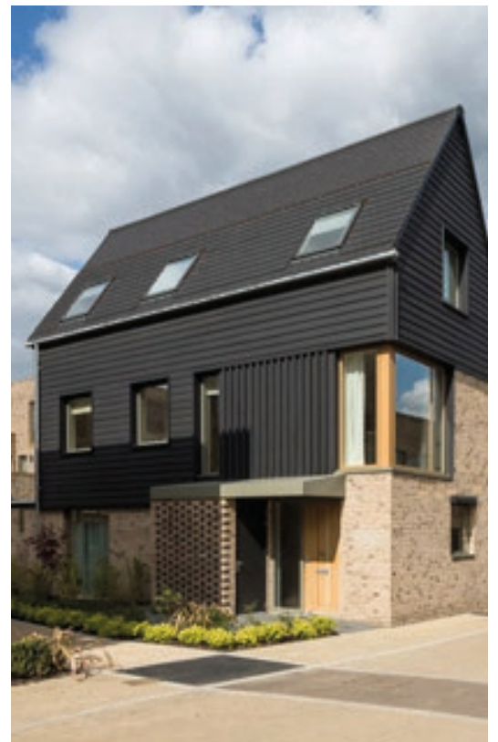
Afb. 3.36 - materialisatie baksteen in combinatie met hout
