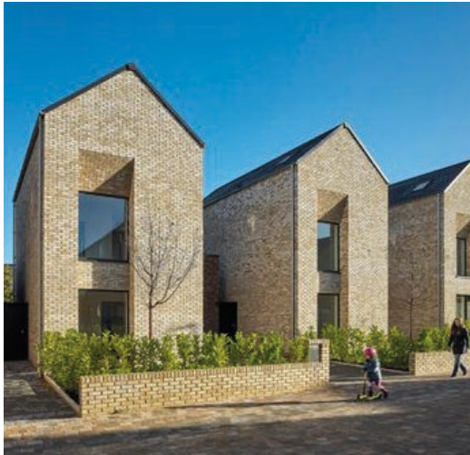
Afb. 3.14 - identieke materialisatie in gevel en erfafscheiding
