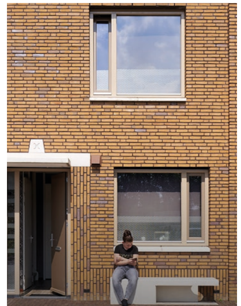
Afb 3.25 - meeontworpen zitelement in de gevel
