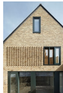
Afb. 2.21 - variatie in metselwerk
