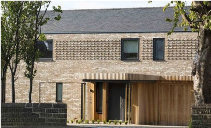
Afb. 2.42 - metselwerk in combinatie met hout
