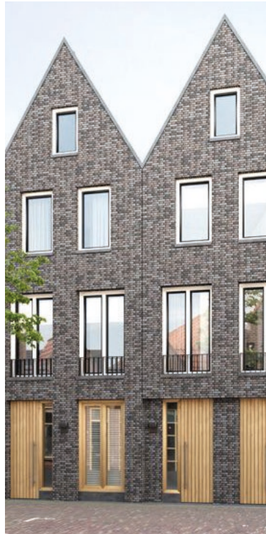
Afb. 3.33 - materialisatie baksteen in combinatie met hout
