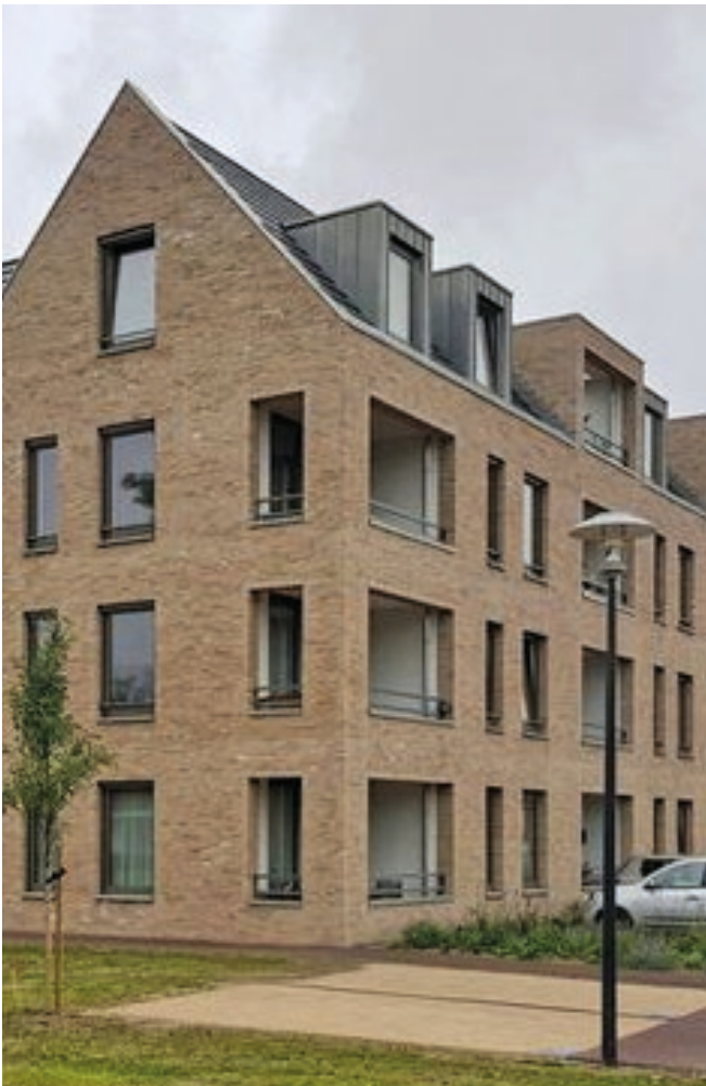
Afb. 3.45 - inbandige balkons en duidelijk afwijkende bovenste etage
