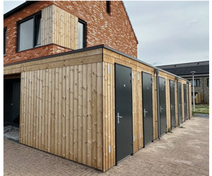
Afb. 2.81 - bergingen aan de zijkant
