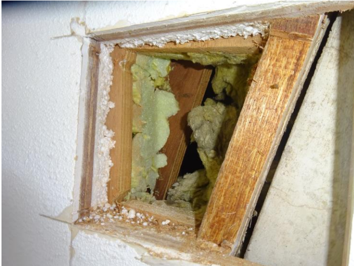
Afbeelding 6a – destructief onderzoek aan binnenzijde zijwang dakkapel
