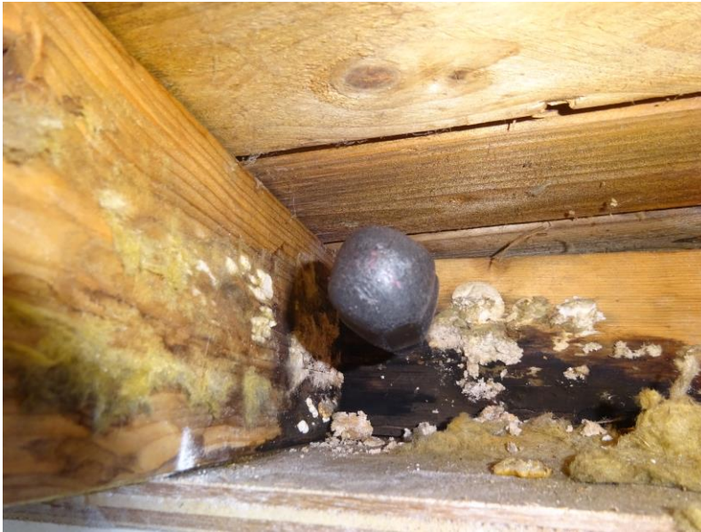
Afbeelding 10a - schimmel/zwam en houtrot
