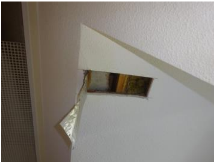
Afbeelding 6b – dampremmende folie in plafond dakkapel
