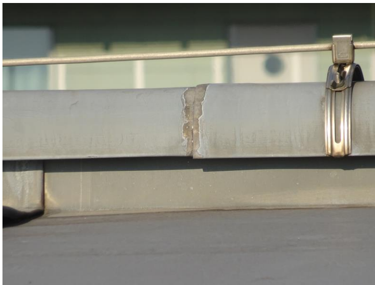
Afbeelding 5 – visuele inspectie nokkap
