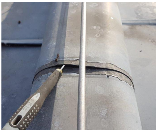
Afbeelding 8 – gescheurde lasnaden in zinken nokkap
