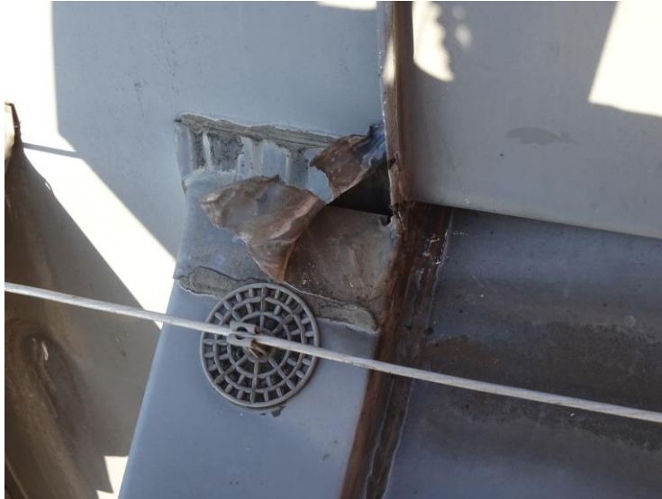
Afbeelding 4 –destructief onderzoek dakkapel, het lood losgemaakt
