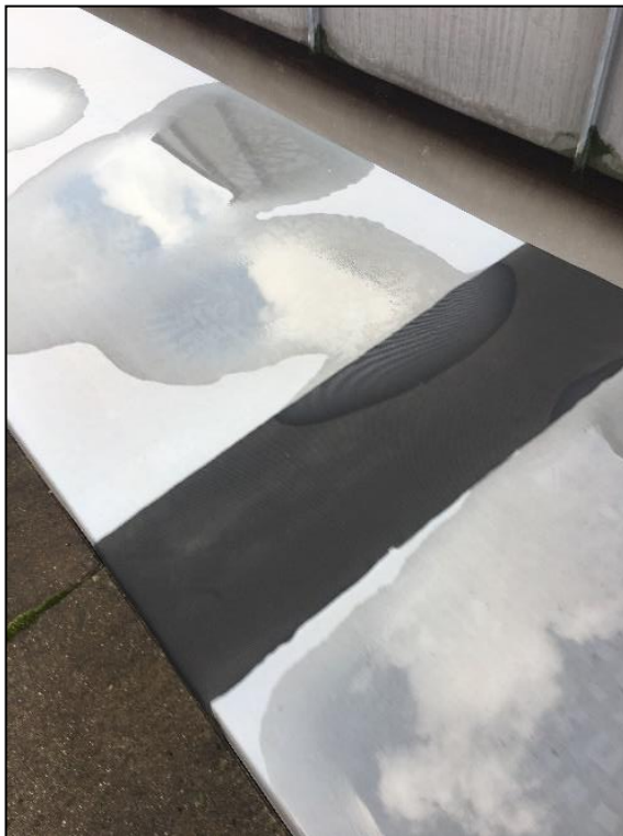
Afbeelding 11a – overlagen van scheuren in het zink
