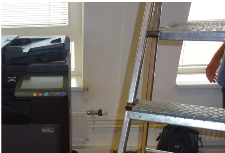
Afbeelding 9b – vochtschade aan dakkapel bouwdeel C
