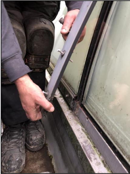
Afbeelding 14a –rubbers en glaslatten zijn in goede conditie
