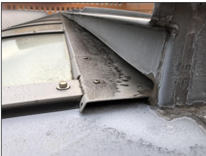
Afbeelding 14c –zinkwerk inclusief lasnaden zijn verouderd maar in goede conditie
