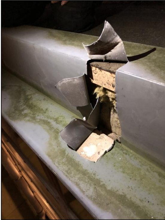
Afbeelding 7c – destructief onderzoek zinken dakrand dakvlak A2
