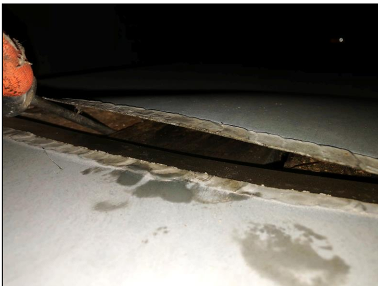
Afbeelding 11b – geen waterkerende laag onder het zink
