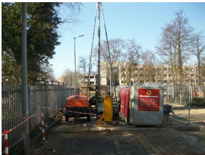
Figuur 2.6 | Opstelling tijdens het ontwikkelen en/of regenereren van een bron.
