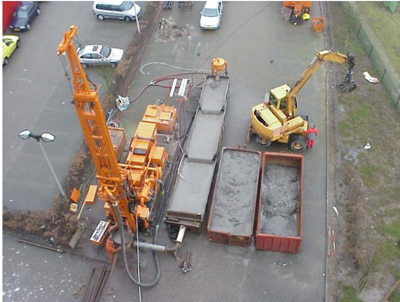
Figuur 2.5 | Opstelling tijdens het boren van een bron.
