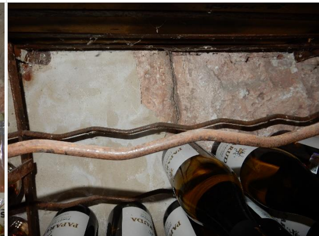
Scheurvorming linkerzijde
