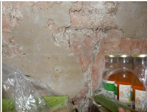
Scheurvorming linkerzijde
