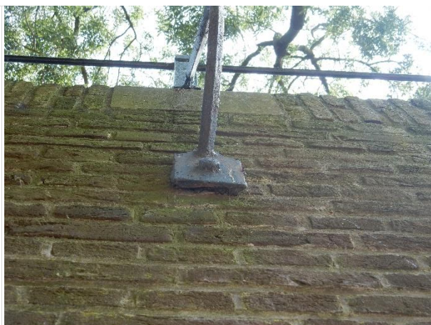
Corrosie hekwerk
