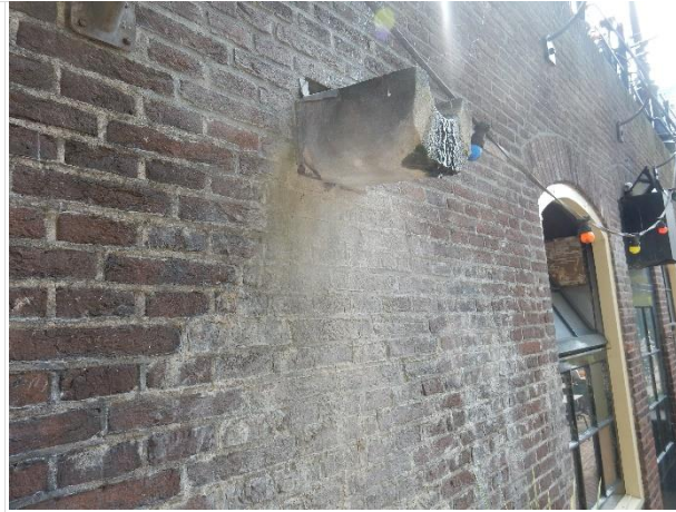
Aantasting metselwerk
