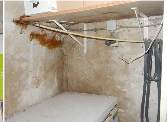
Aantasting pleisterwerk
