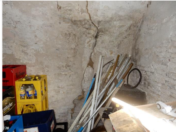
Scheur wand linkzijdig
