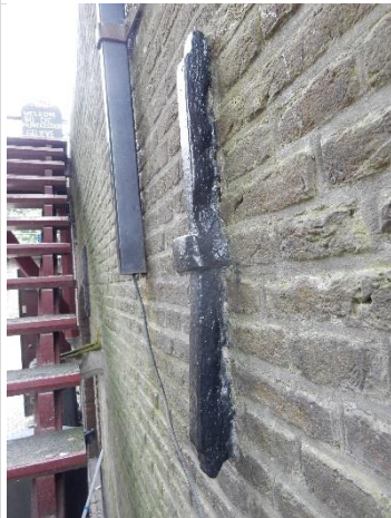
Spanning op muuranker
