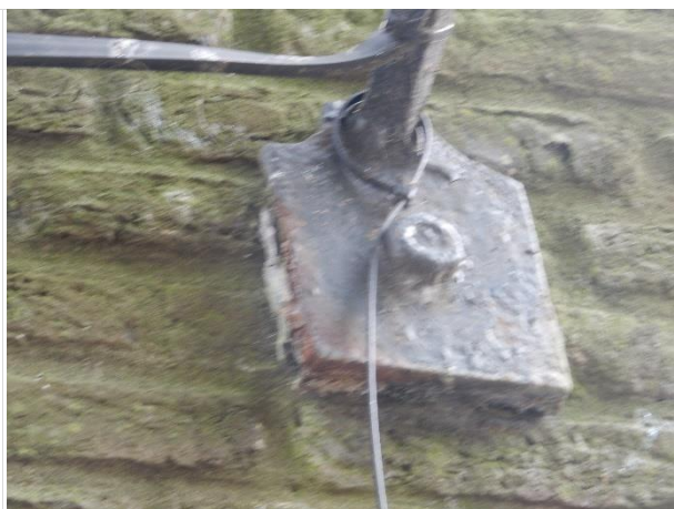
Corrosie hekwerk
