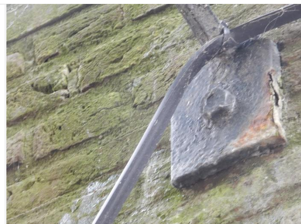
Corrosie hekwerk
