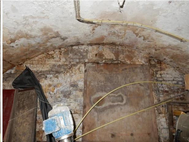
Later dichtgezette achterwand met doorgang
