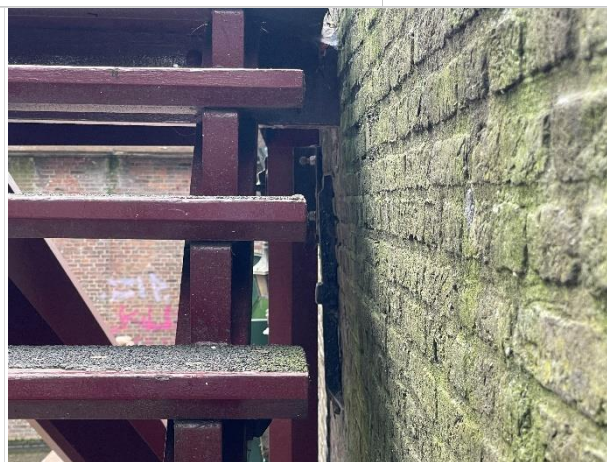
Bovenste deel werfmuur kijkt naar de werf toe
