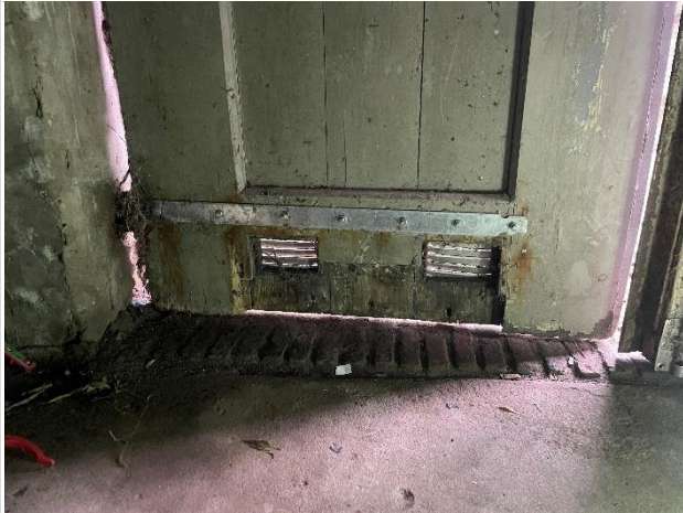
De onderste klampen ontbreken
