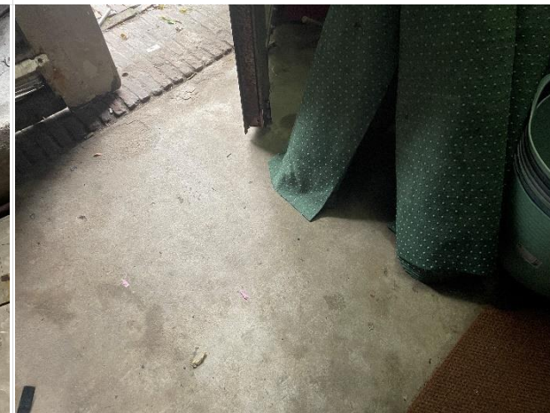
Dekvloer voorzien van tapijt (ca 80%)
