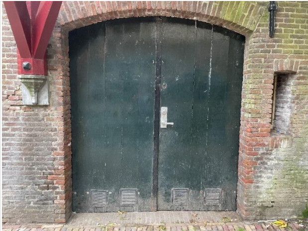
Dubbele houten deuren met modern beslag
