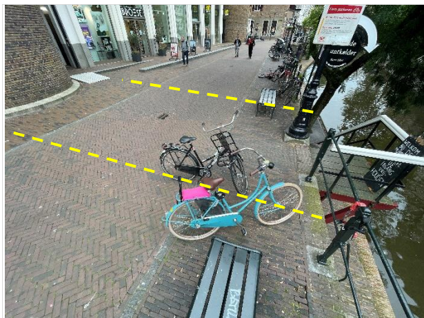
Overzicht straatwerk boven werfkelder
