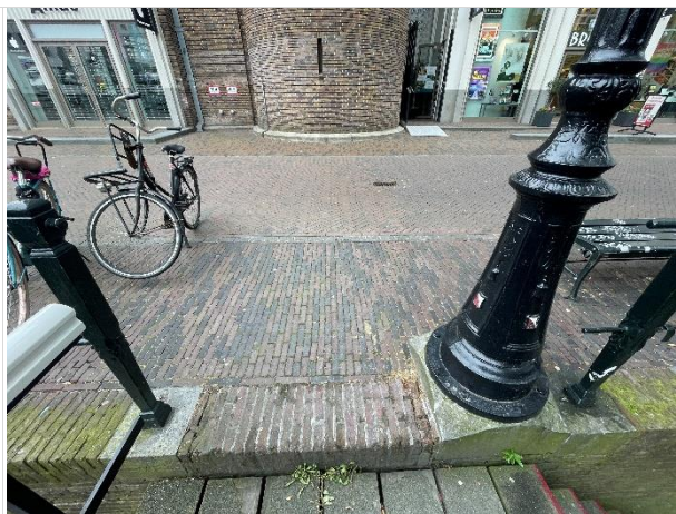
Overzicht straatwerk en ingang trappartij
