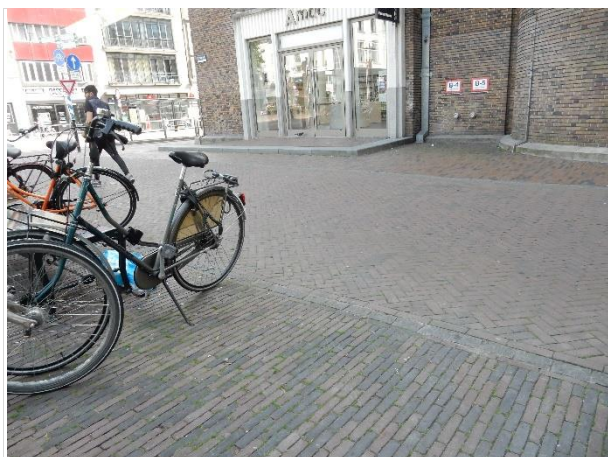
Overzicht straatwerk boven werfkelder
