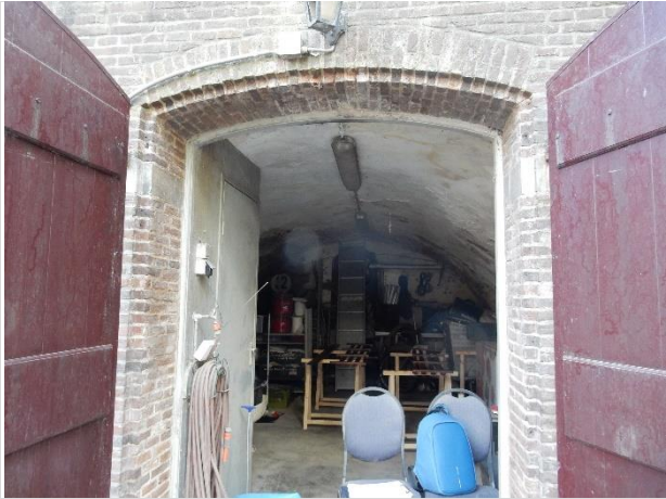
Overzicht kelder vanaf werf
