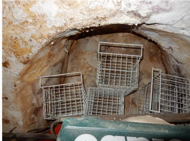
Oude doorgang naar kelder 112-E
