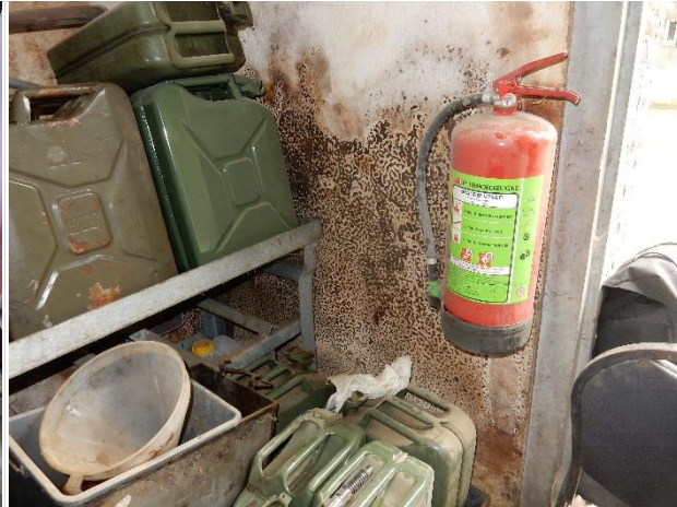
De binnenzijde van de deuren, naast de deuren een draairaam
