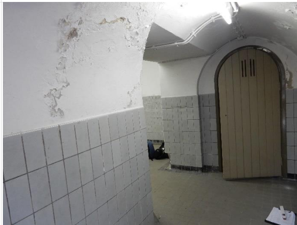
Houten deur en kozijn naar berghok
