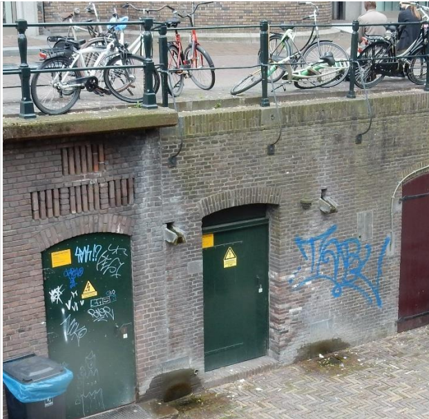
Aanzicht van de kelder
