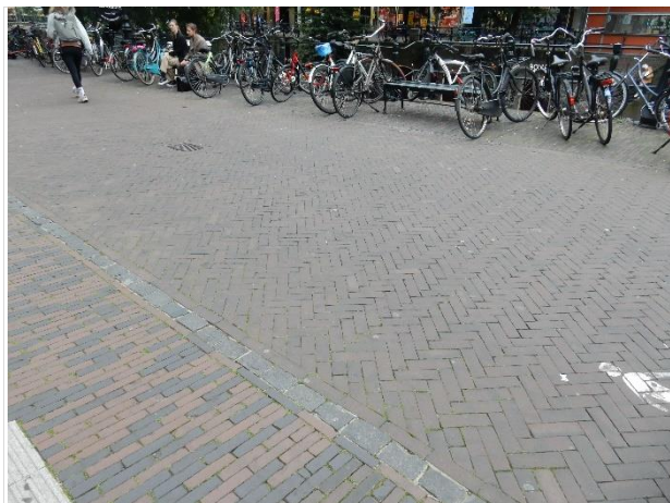
Overzicht straatwerk boven werfkelder
