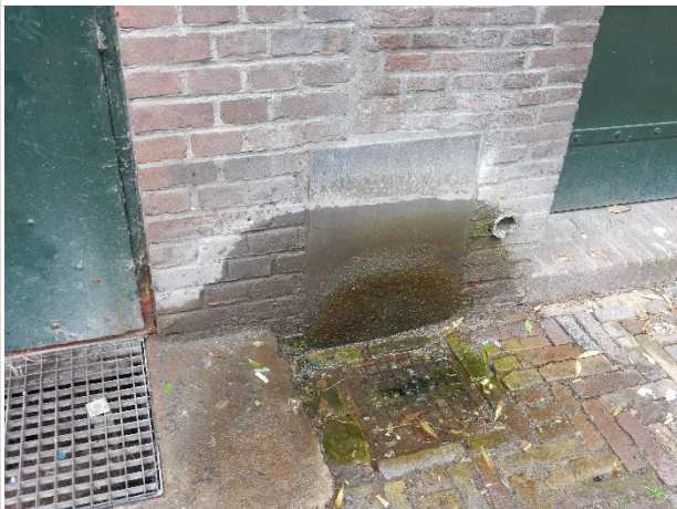
Vochtbelasting en mosbegroeiing natuursteen en baksteen
