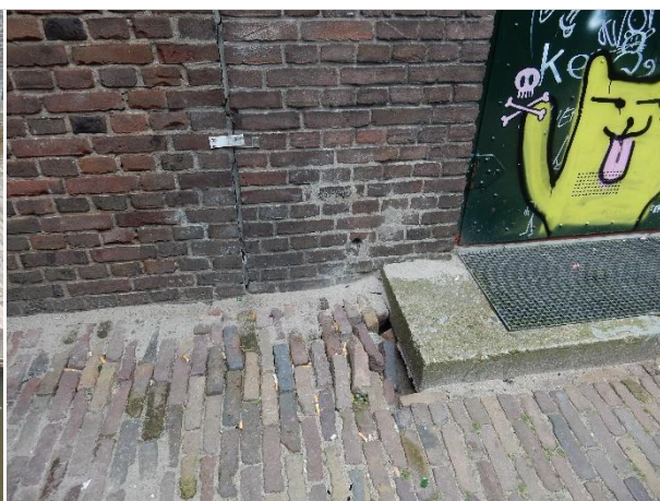
Verzaking zandpakket en bestrating naast koekoek
