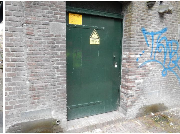
Deurkozijn en deur
