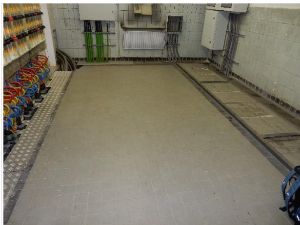
Overzicht kelder 112, tegelvloer
