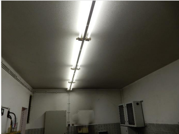
Plafond, geen gebreken
