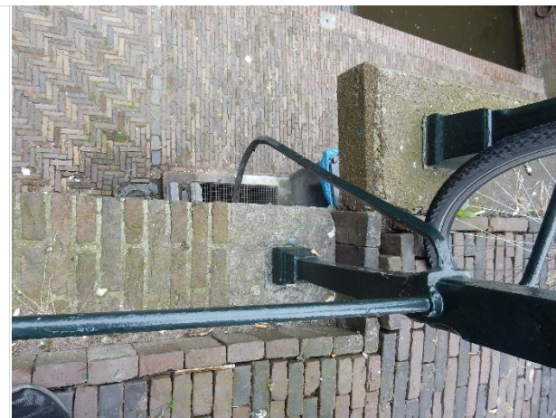
Straatwerk verhoogd, aansluiting ligt los
