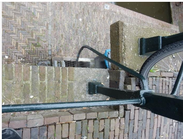
Straatwerk verhoogd, aansluiting ligt los
