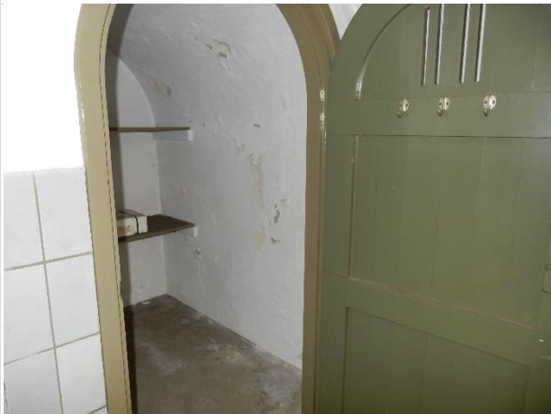
Houten deur en kozijn naar berghok
