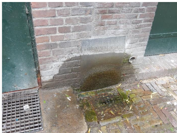
Veel vochtbelasting door druppelen waterspuwer
