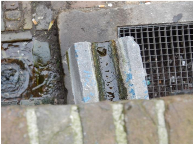
Aantasting spuwer door hemelwater
