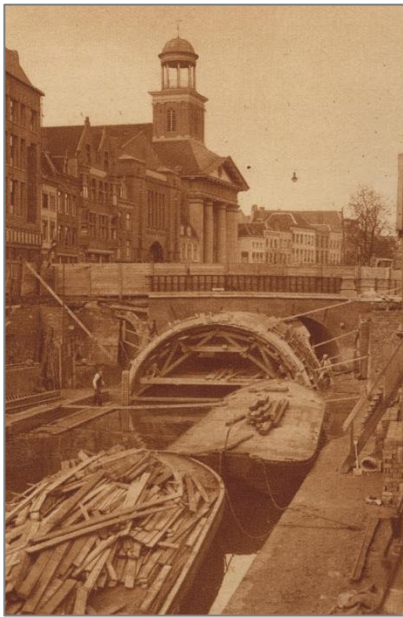
Figuur 15: Verbreden Viebrug
