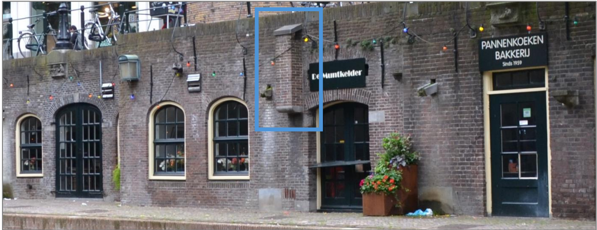
Figuur 11: Schoorsteen bevestigd aan de werfmuur
