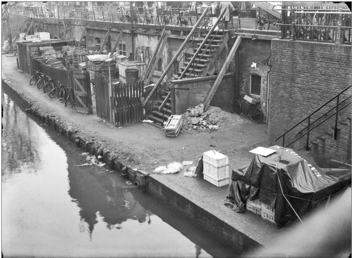
Figuur 2: Gezicht op een opslagplaats aan de werf tussen de Viebrug en de Jansbrug. Mogelijk werd hier al deels gewerkt aan het herstel van het wervengebied
