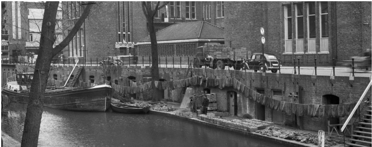
Figuur 5: Oudegracht 112 na de bouw van het postkantoor
