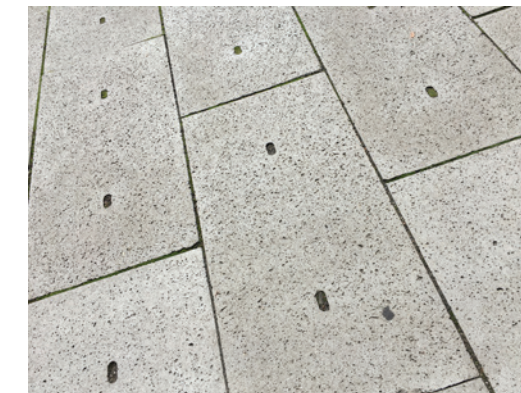
betonplaat Groene Loper en entreezones
