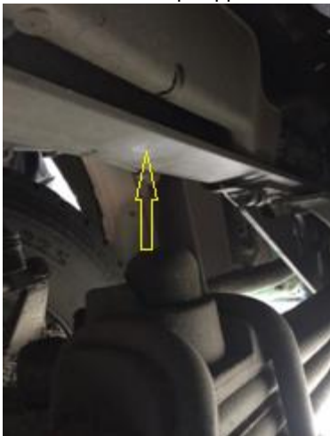
Afb.: Veerweg tussen bumpstop en langsligger. Bron: M. Krol, Brandweer Nunspeet.
