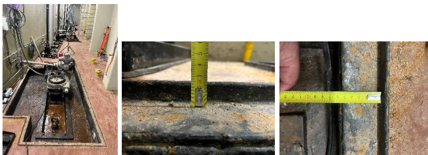
Foto's detail stalen profielen in de vloer rondom tolklep.
