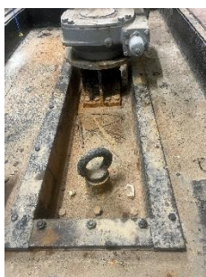
Foto stalen profielen in lager gedeelte rondom tolklep.
