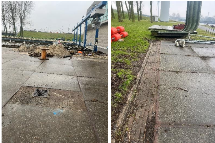
Betonnen industrieplaten op terrein zuidoostkant naast instroomzijde.
