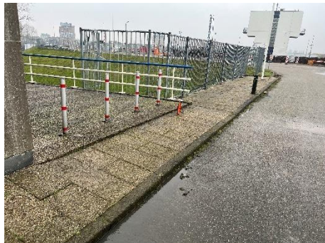
Foto straatwerk trottoir bij hoofdingang.
