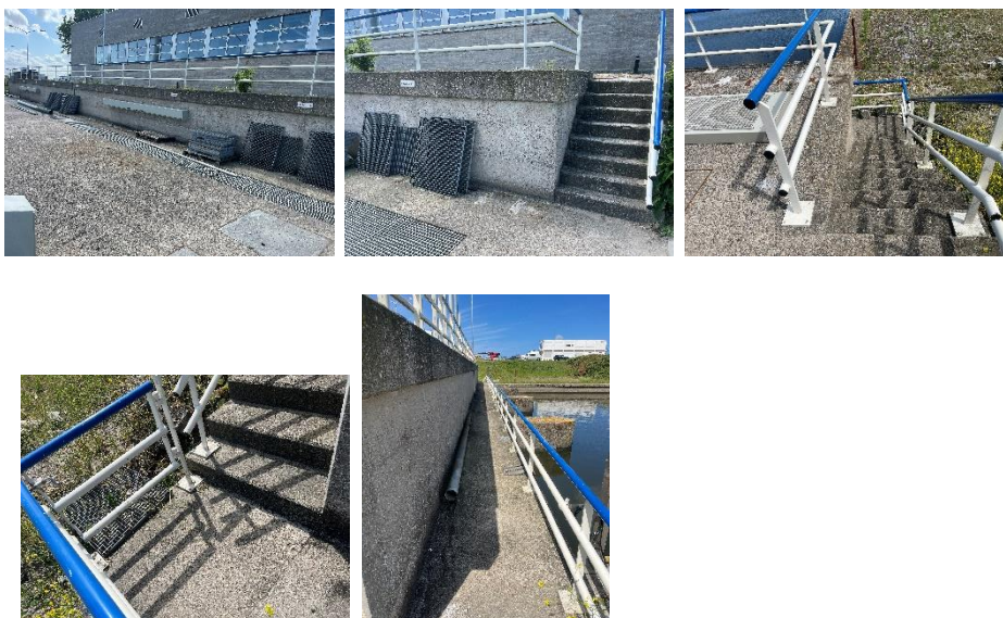
Foto's beton uitstroomzijde.
