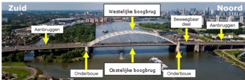
Figuur: Schematische weergave van de Van Brienoordbrug
