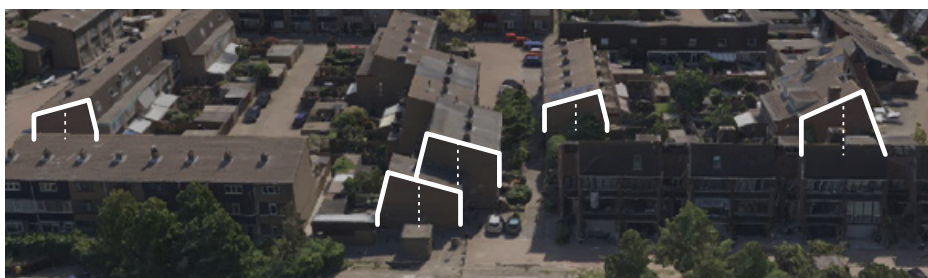
▲ De bestaande bebouwing rondom de Haydnlaan heeft asymmetrische daken.
