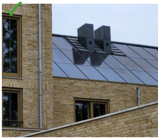
▲ Wel: afvoeren geclusterd in een dakdoorvoer
