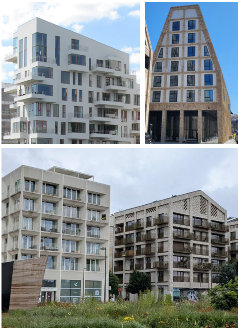
▲ Daken zijn overwegend plat. Incidenteel is een afwijkende dakvorm mogelijk.
