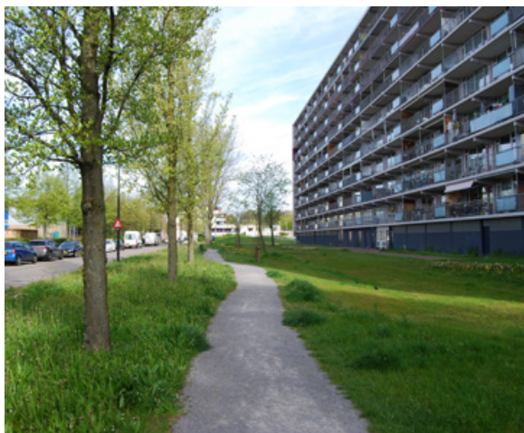
▲ Recent aangelegde wadi langs de Haydnlaan.
