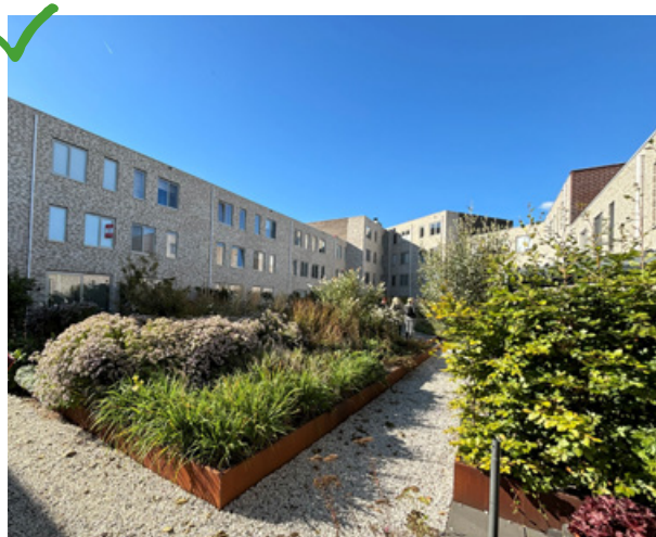
▲ Wel: collectieve tuinen met voldoende gronddekking boven parkeervoorziening bewoners.
