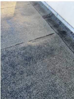
Zit ergen hoge blaas vorming in de bedekking
