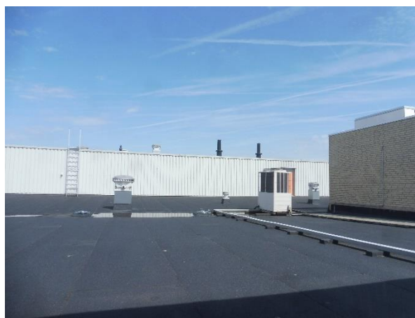
Inkijk op een dakgedeelten.
