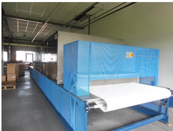
Microwavelijn, nieuw geplaatst met de installatie nog onder constructie tijdens het bezoek.
