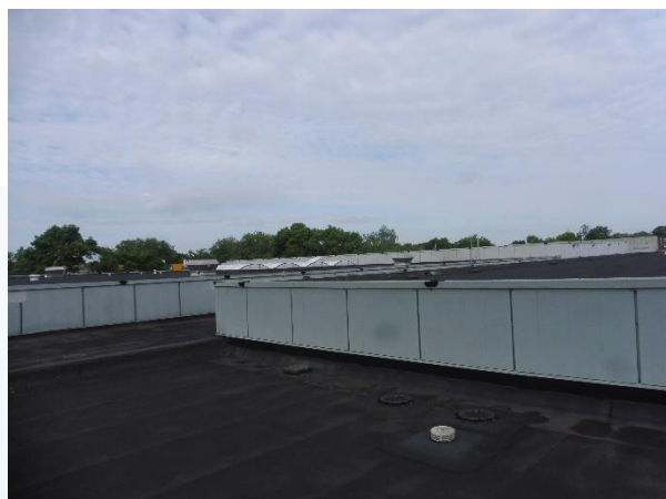
Gebouw 1: inkijk op het dak.
