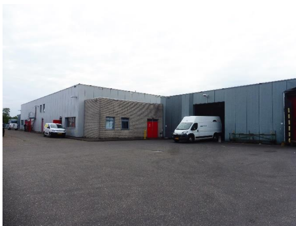
Gebouw 1: situatie aan de achterzijde.
