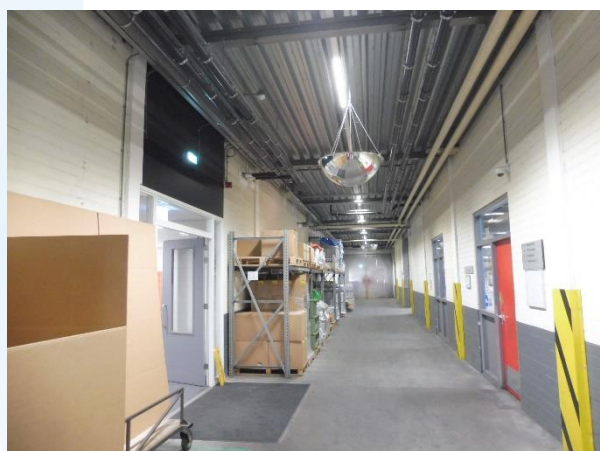
Gebouw 1: inkijk in een verkeersgang.
