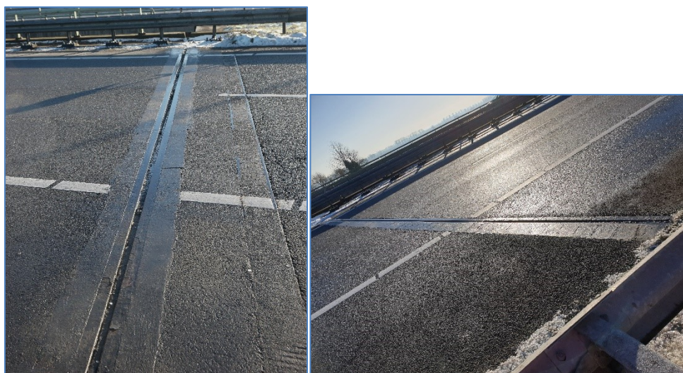
Figuur 10 (Links) Enkelvoudige voegovergang bij steunpunt 1 en (rechts) enkelvoudige voegovergang bij steunpunt 5 (tek. 501934-1 en 501934-5/6)
