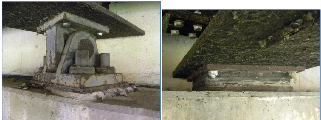
Figuur 9 (Links) Trek-drukoplegging en (rechts) rubberoplegging (tek. A 60811 en 27652-7)
