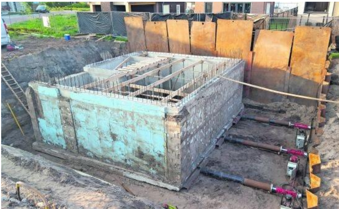
Een vrij gegraven kelder, in dit geval bedoeld om te verplaatsen en opnieuw te gebruiken.
