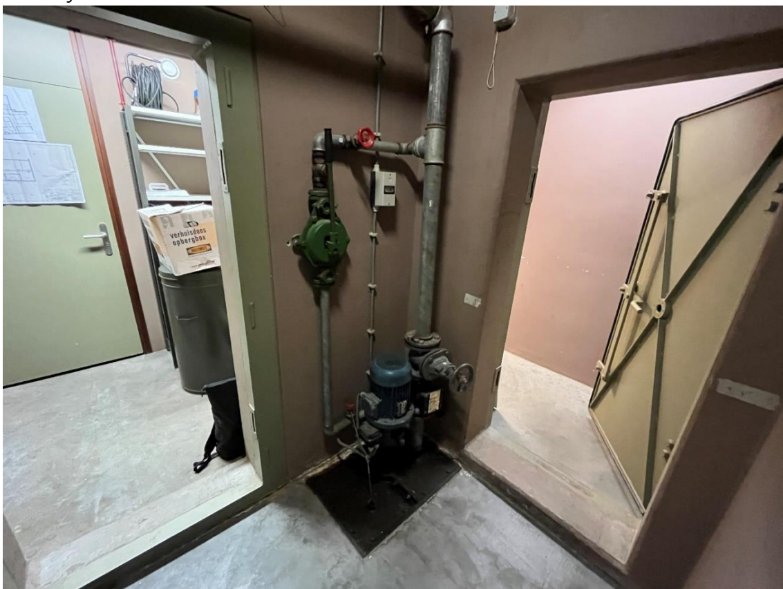
overzicht vanuit compartiment 1, met rechts de hoofdingang, in het midden de vuilwaterpomp en rechts de deur naar compartiment 2
