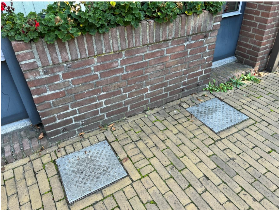
Afdekroosters op de luchtinlaatkanalen en bevestigingspunten op de gevel voor bevestiging opzetkanalen.
