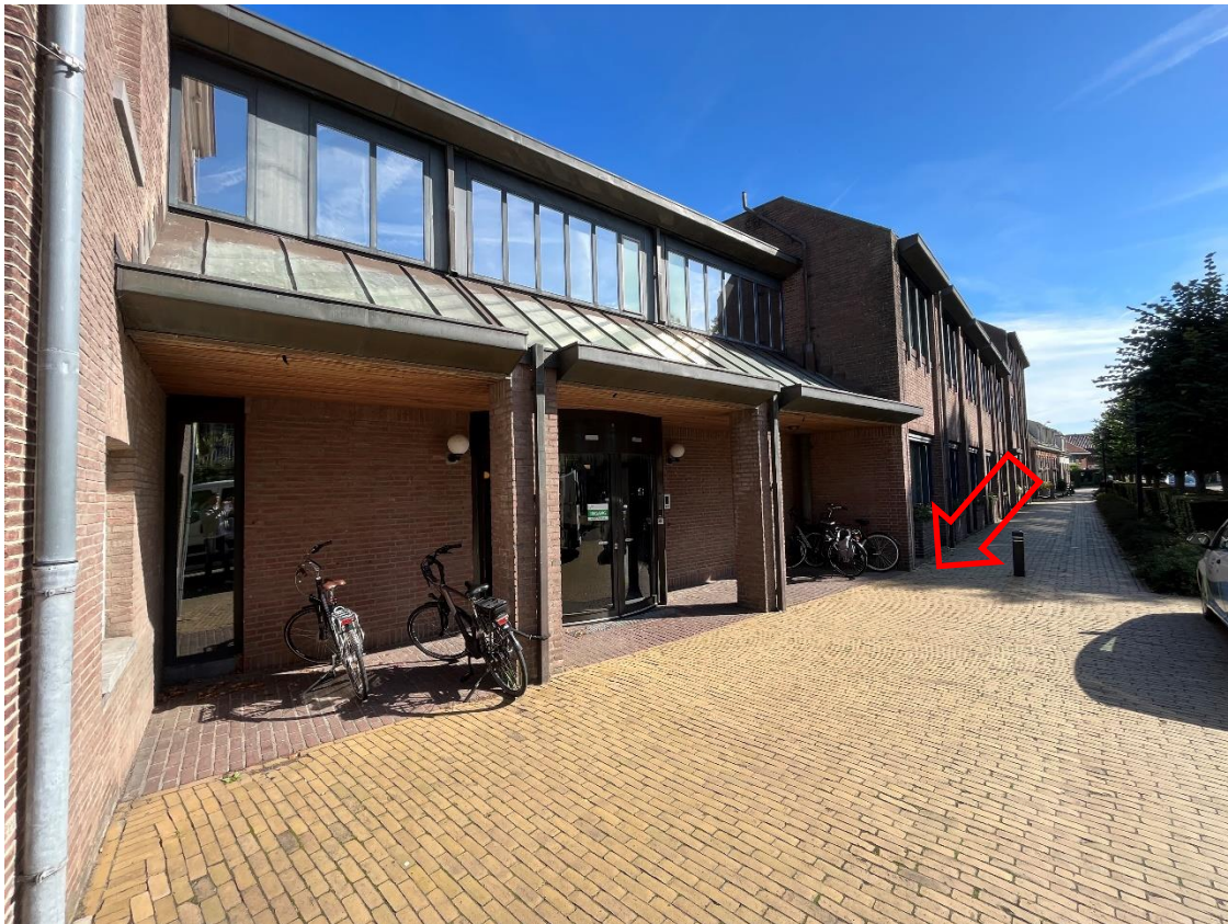
Foto voorgevel voormalige entree. Onder het rechtergedeelte bevindt zich de noodbestuurspost als onderdeel van de volledige onderkeldering.
