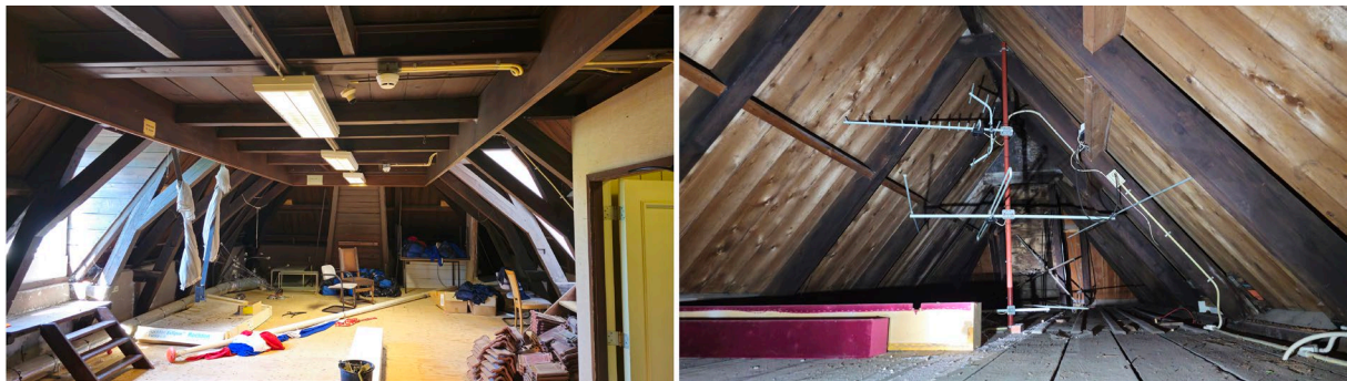
Figuur 40. De kapconstructie uit 1771 in het voorhuis met links een overzicht van de zolder met verschillende spanten met kreupele stijlen achter elkaar. Rechts is de kapconstructie boven de vloering zichtbaar met nokgording en spijkerplaat.
