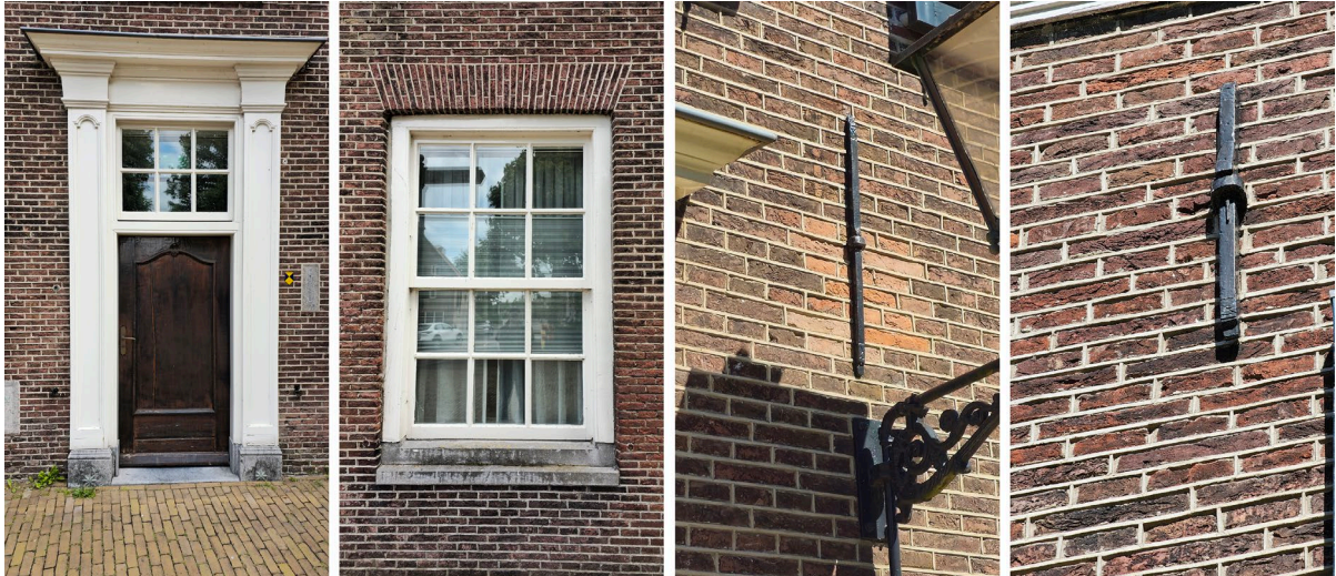
Figuur 33. Details van de voorgevel van het raadhuis. Uiterst links een overzicht van de classicistische voordeur met 18 e -eeuwse ornamentiek. Links een van de twaalfruits schuifvensters met dubbele onderdorpel. Rechts een van de slanke muurankers boven de begane grond daterend uit 1743 en uiterst rechts een van de muurankers uit 1771 op de verdieping.
