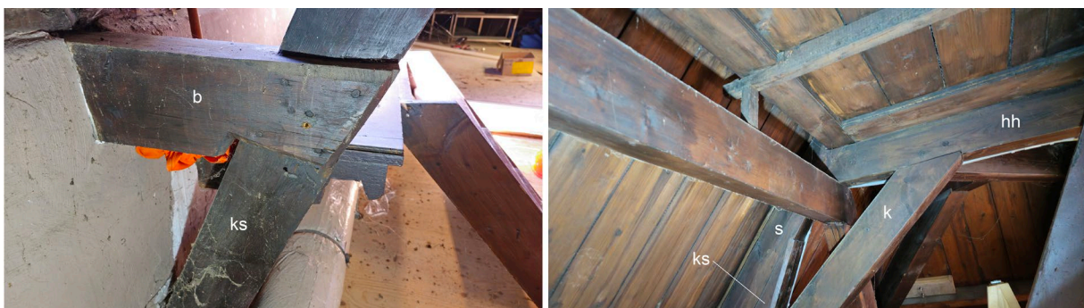
Figuur 41. Details van de kapconstructie van het voorhuis met links een detail van een kreupele stijl (ks) verbonden door een blokkeel (b) aan de borstwering. Rechts een detail van de aansluiting van de kreupele stijl (ks) op de spruit (s). Deze spruit is weer verbonden met de hanenbalk (hh). Kreupele stijl en hanenbalk zijn verbonden door een korbeel. (k)
