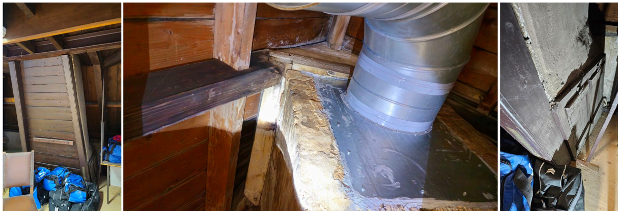
Figuur 66. Overzichten van schoorstenen op de zolderverdieping. In het midden de rechter schoorsteen van het achterhuis en aan weerszijden daarvan de linker schoorsteen van het voorhuis.
