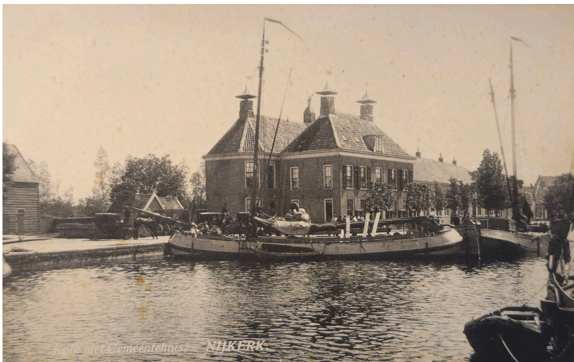
Figuur 18. Historische foto van het oude raadhuis van voor 1938 (NA). De achterste schoorsteen is hier anders uitgevoerd als de ander drie en het achterhuis heeft op de begane grond een rond venster dat nog behoort bij de oorspronkelijke indeling.
