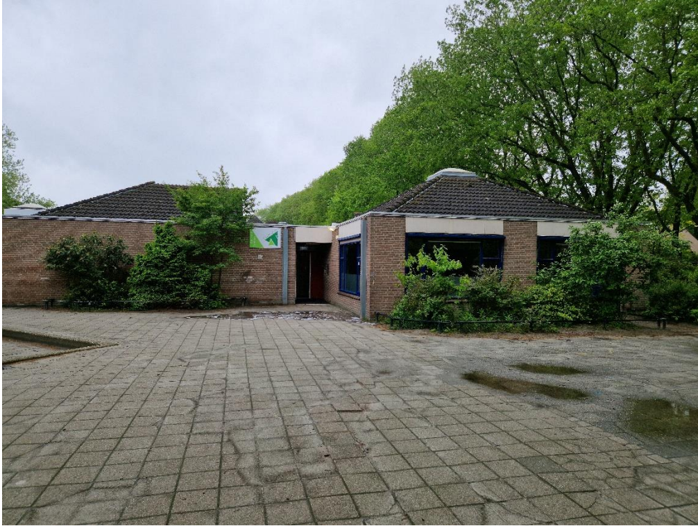
Figuur 9. Het plangebied betreft een gebouw van één bouwlaag, een bijgebouw en de grotendeels bestrate omgeving ervan.
