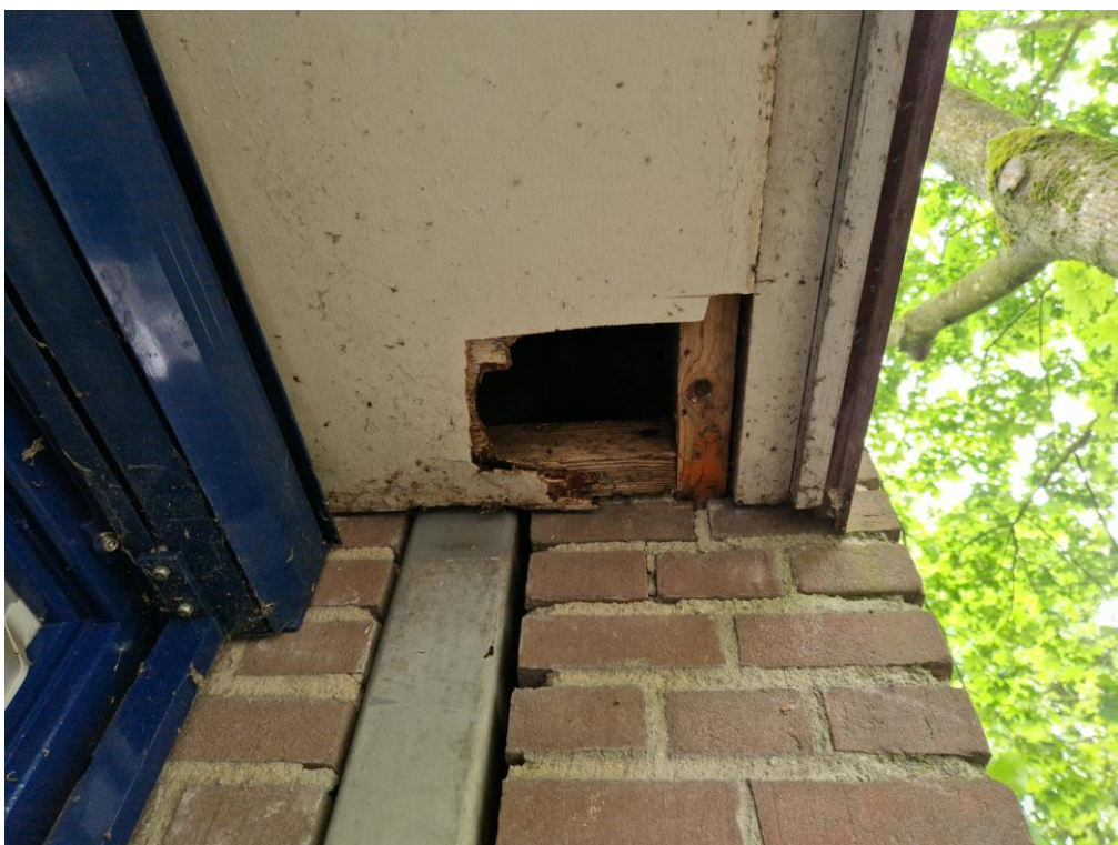
Figuur 12. Bij het hoofdgebouw is een gat in een dakrand aanwezig. Mogelijk wordt dit als toegang door een steenmarter gebruikt.
