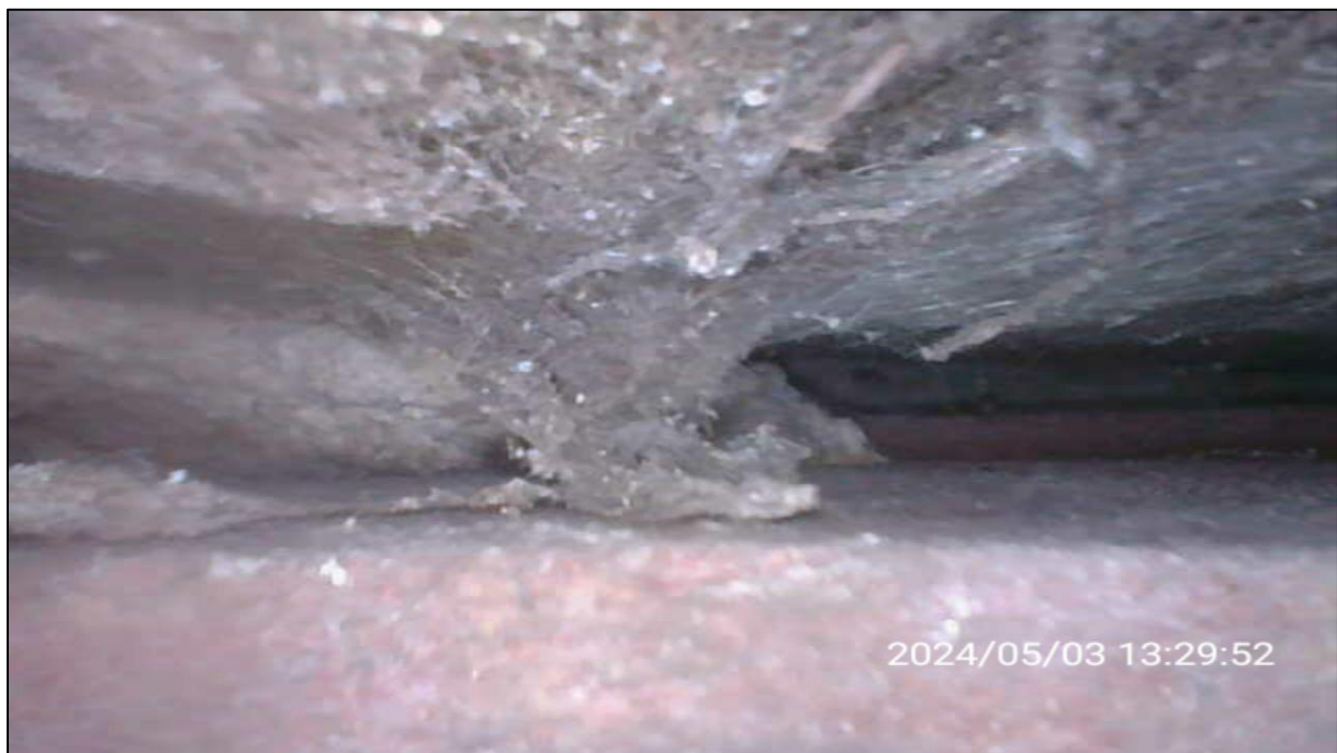
Figuur 2. Bij het onderzoek is een spouwendoscoop gebruikt. Daarmee kon worden vastgesteld dat de spouw geïsoleerd is, en dat er een restruimte aanwezig is van enkele centimeters breed.
