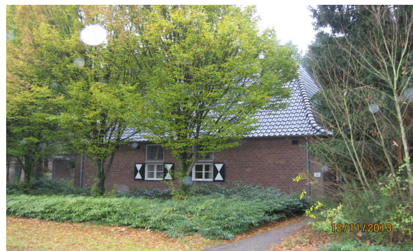
Zijaanzicht bouwwerk links
