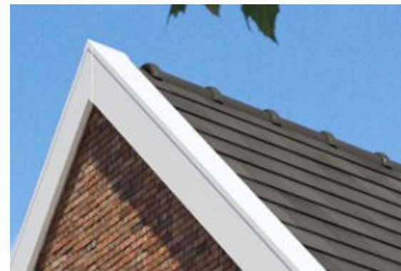
Figuur 20 Windveer voor toegang tot dakbeschoot.
