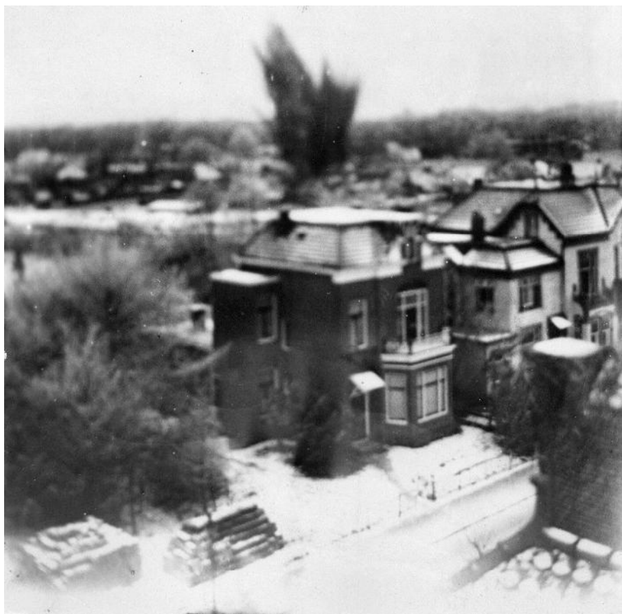
Figuur 32: Het laten ontploffen van een blindganger in de Esstraat te Assen.
