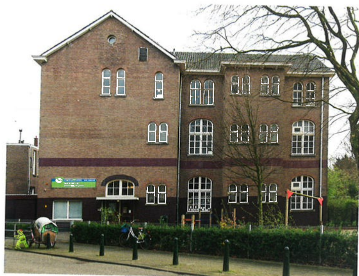
BOVEN • De nieuwe kleuterschool uit 1955, op de plaats van de afgebroken paardenstal. Rechts een stukje van de achtergevel van de Sint Vincentius ulo.
