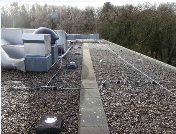
Overzicht dak nieuwe gebouw
