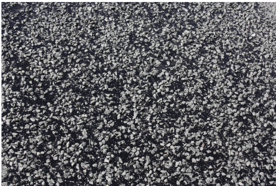
Figuur B6.5 Informatief: goed afgestrooid membraan (circa 50% bedekt)
