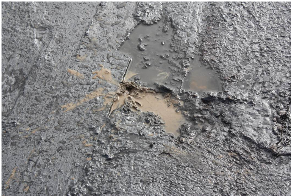
Figuur B6.2 Informatief: Niet uitgevuld “gat”, gevuld met vuil water
