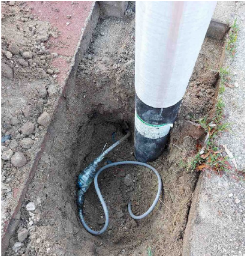
Foto nieuwe situatie, lichtmast voldoende afgevuld met zand
