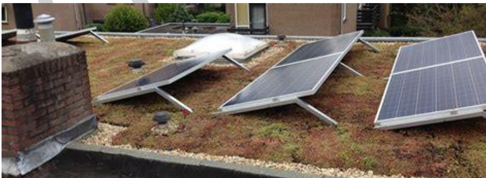
Op bepaalde plaatsen kunnen sedumbepanting en zonnepanelen gecombineerd worden
