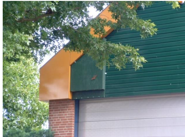
Ook aan de achterkant van de brandweerkazerne werd een grote vleermuiskast aangebracht
