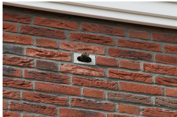
Cementbetonnen nestkast geheel in de spouwmuur ingemetseld. Een voorzetsteen met invliegopening geeft toegang tot het nestgedeelte
