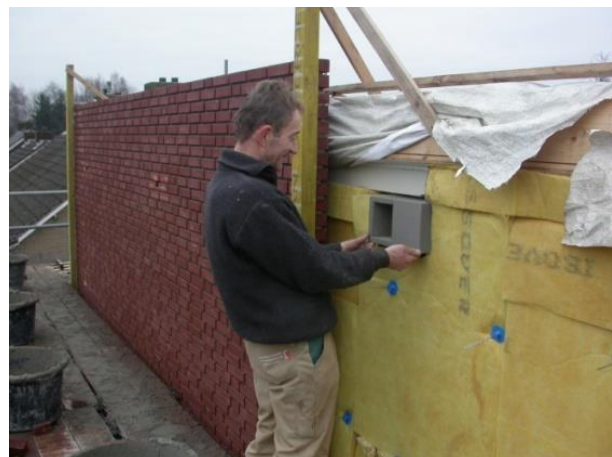
De nestkasten werden tussen de schouwmuur-isolatie ingemetseld
