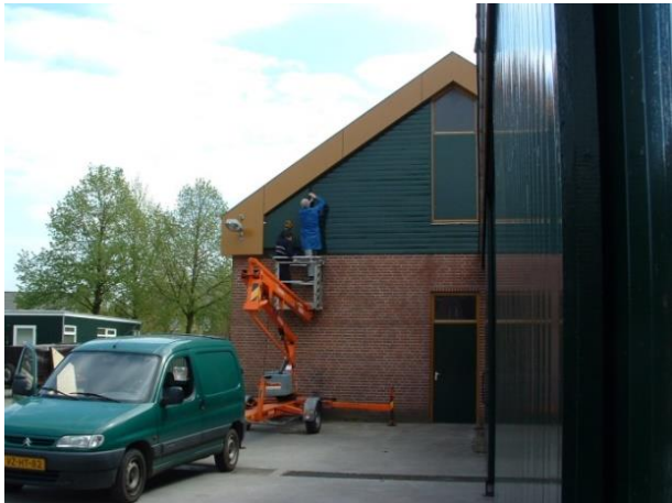
Een zware vleermuiskast werd met een hoogwerker aan de voorgevel van de brandweerkazerne van Diessen bevestigd . De vorm van de vleermuiskast volgde de daklijn.
