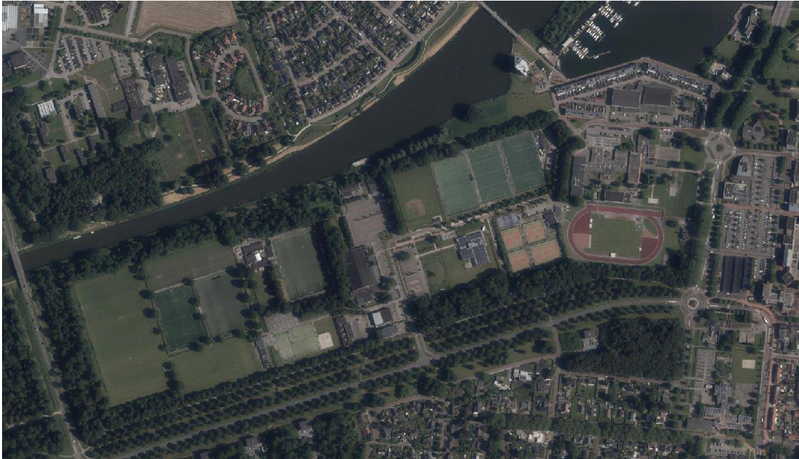
Figuur 1 Locatie burgemeester Dekker Sportpark te Dronten (luchtfoto)
