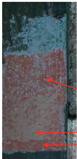
kleurtrap en doorsnede stalen kozijn
