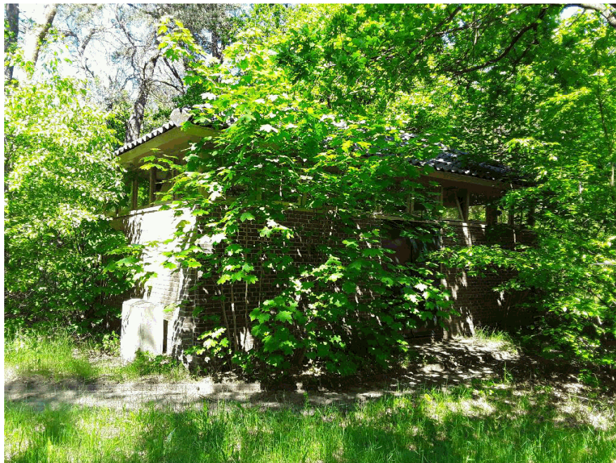
40B18E5, buitenzijde gebouw
