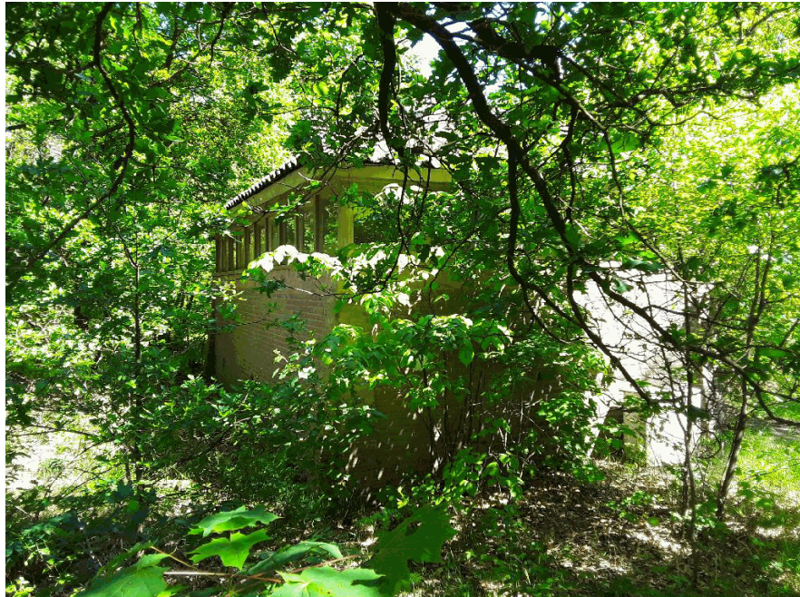
40B18E5, buitenzijde gebouw
