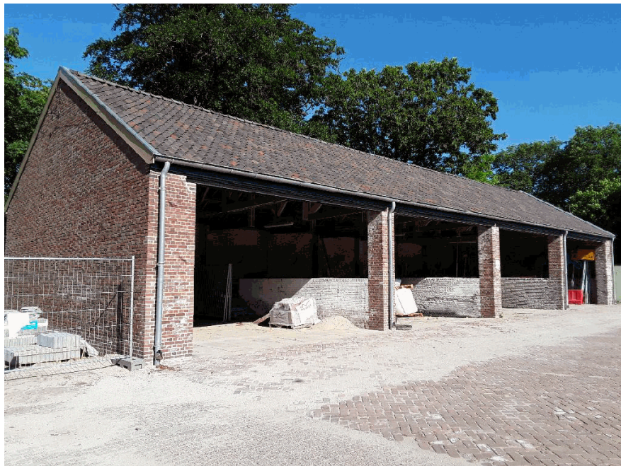
40B1 844, buitenzijde gebouw
