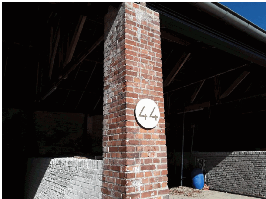
40B1 844, buitenzijde gebouw
