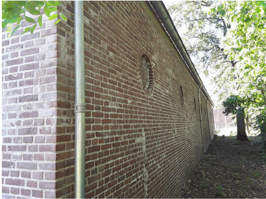
40B1844, buitenzijde gebouw
