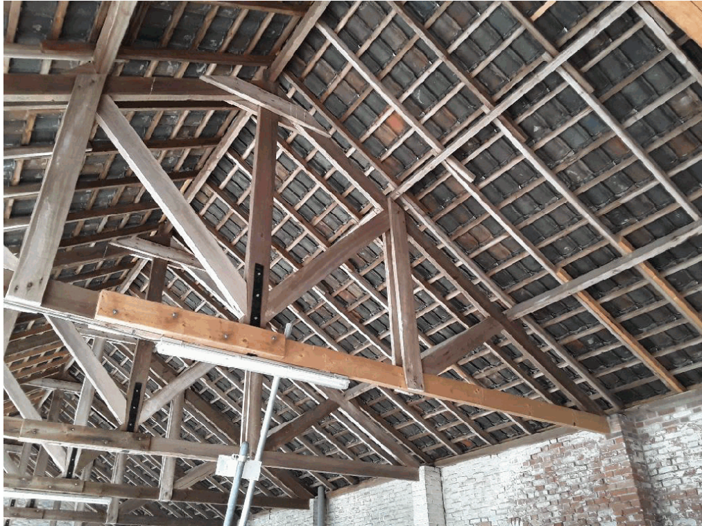
40B1 844, geen dakbeschot aanwezig
