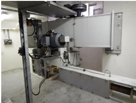
Aandrijving en bewegingswerk, elektromechanisch, -, puntdeur
