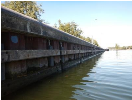
Kerende constructie, staal, grond
