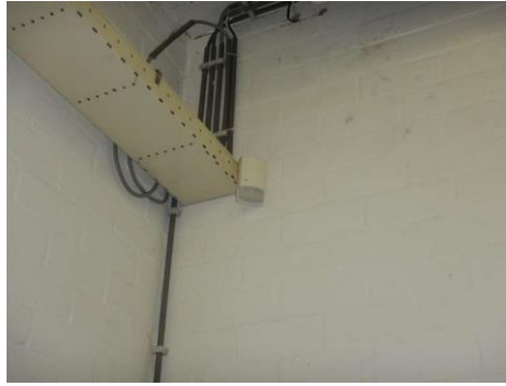
Kabeldraagconstructie, -, staal
