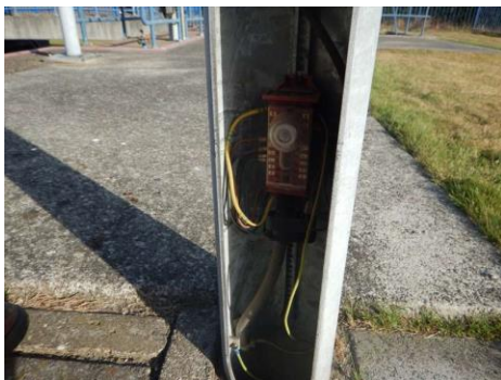
Aarding- en bliksembeveiligingsinstallatie, -,
