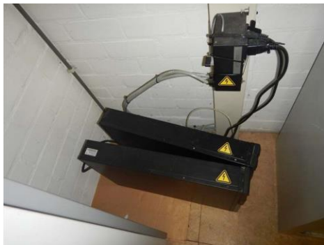
Noodstroominstallatie, statisch, -,
