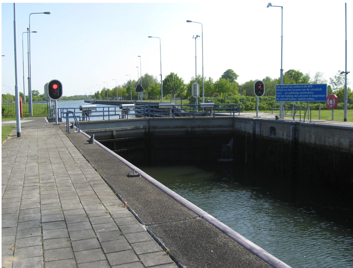
Figuur 1. Sluis Helmond (Grontmij, inspectie 2010)
