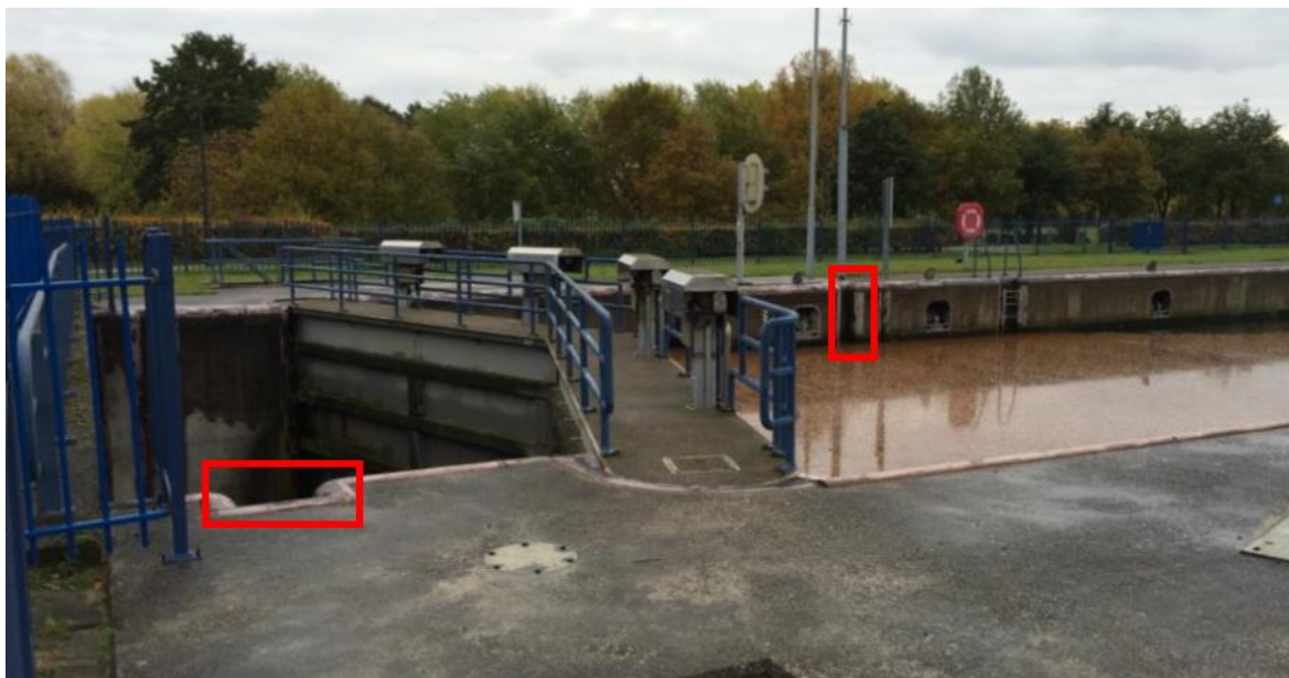
Figuur 2-2 Foto benedenhoofd sluis Helmond met sponningen aangegeven
