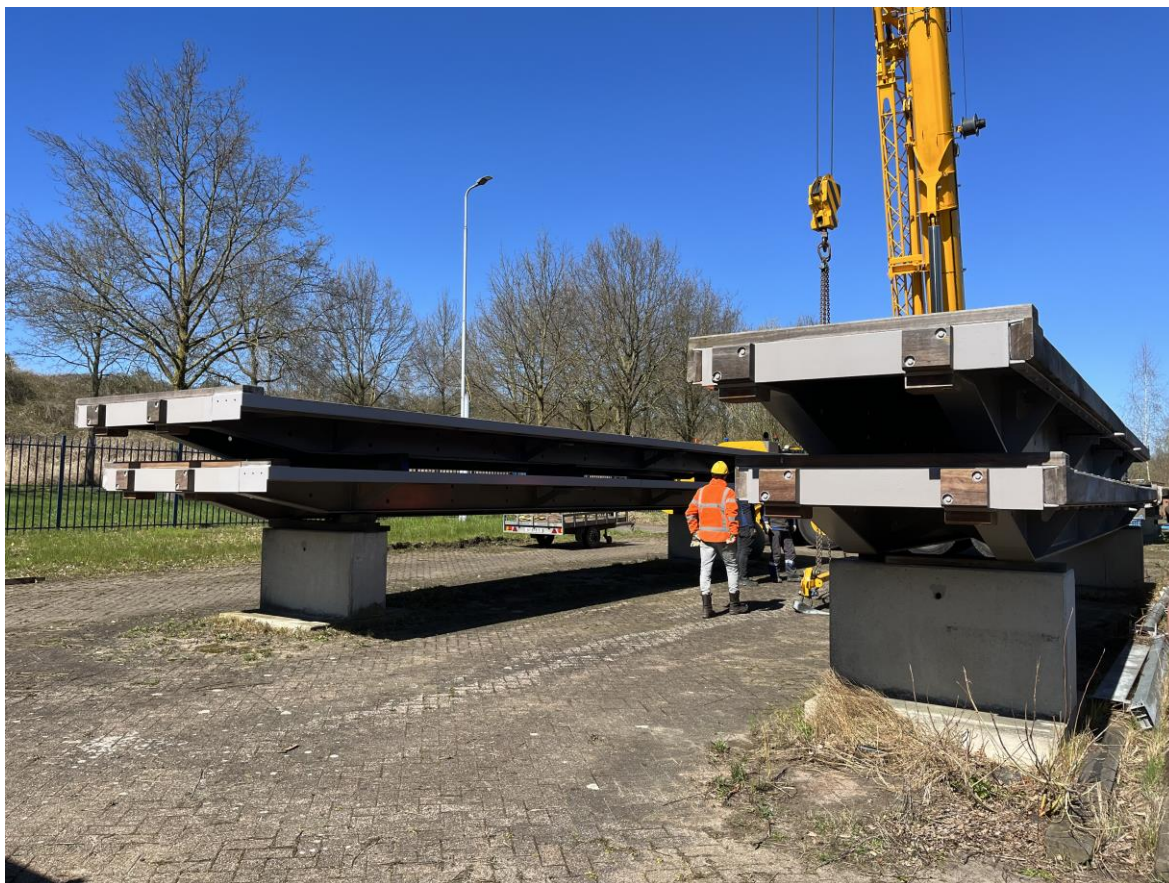
Figuur 3-1: Een van de twee bovenschotten dat op het andere bovenschot gehesen wordt
