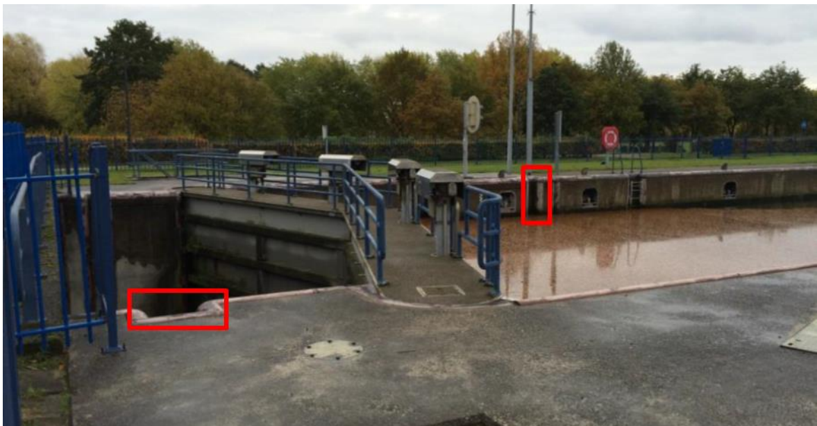
Figuur 4-3 Sponningen sluis Helmond met rood aangegeven
