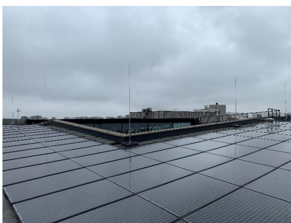
Gebouw 2: inkijk op een dakgedeelte.
