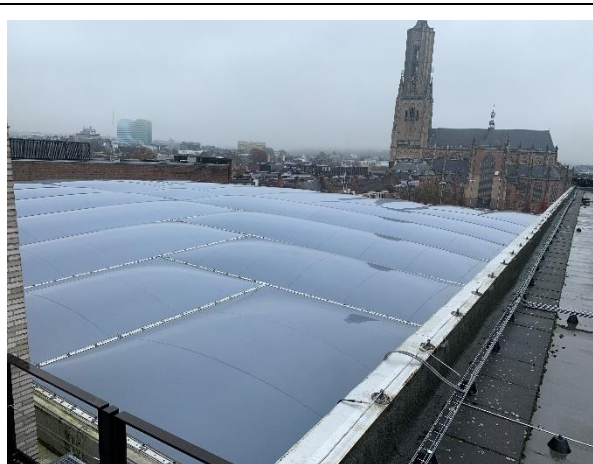
Gebouw 1: inkijk op een dakgedeelte.
