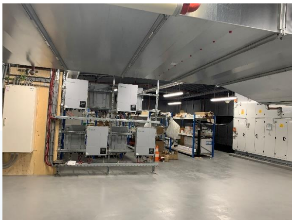
Gebouw 2: inkijk in een technische zolder.
