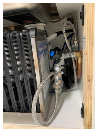
Watervoerende apparatuur op verdiepingen.
