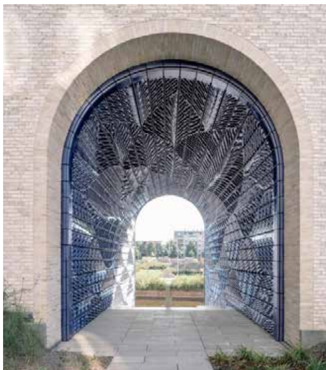
Poort ontworpen door Studio RAP in het project Poortmeesters in Delft als referentie van een bijzondere poort richting een collectieve binnentuin
