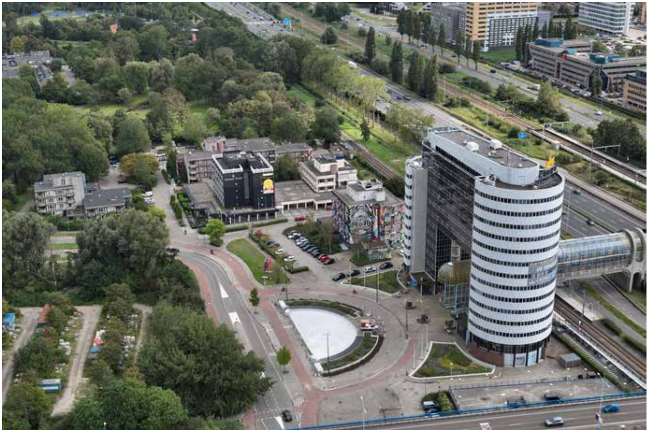
Luchtfoto van Entreeport met het Arianepark op de achtergrond, rechts in beeld zijn het Poortgebouw en de Nelson Mandelabrug over de A12 en de spoorlijnen te zien
