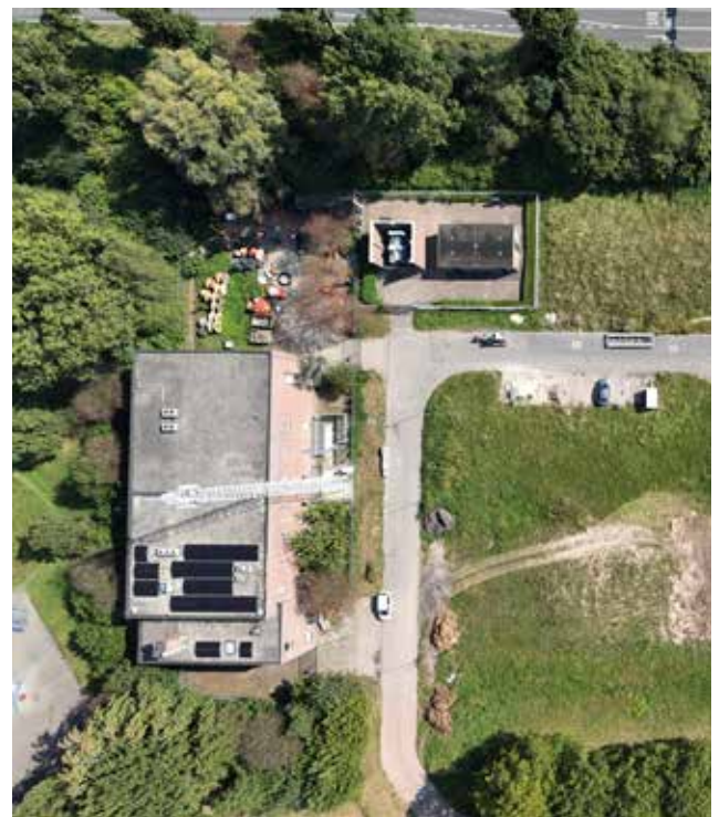
Luchtfoto van het toekomstige kavel West 8 ter hoogte van het KPN gebouw en het onderstation van stedin (Abdissenbos 7 en 9)
