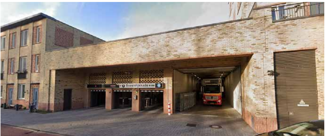
Entree parkeergarage Kooiplein in Leiden ontworpen door Geurst & Schulze architecten als referentie voor een zorgvuldig vormgegeven garage-entree. In dit geval is deze gecombineerd met de expeditie voor de naastgelegen supermarkt.
