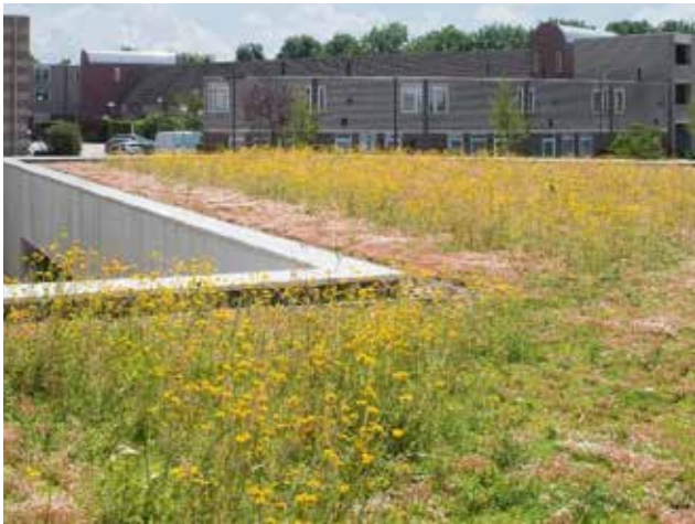
Referentiebeeld extensieve daken
