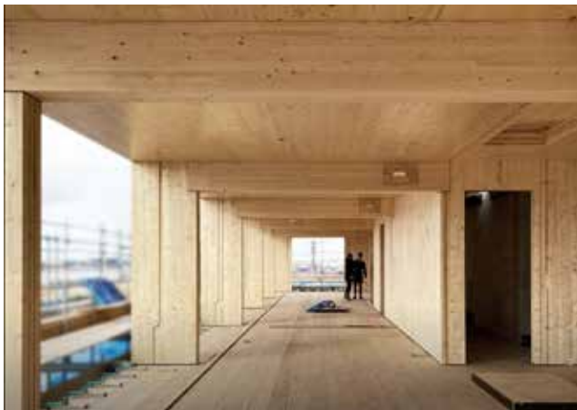
Referentiebeeld van een woongebouw van Cross Laminated Timber (CLT) als voorbeeld van biobased bouwen
