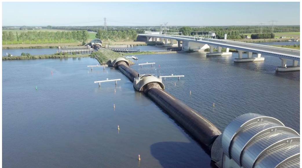
Figuur 1: Stormvloedkering Ramspol in waterkerende vorm
