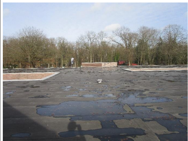
Dak van gebouw 3.
