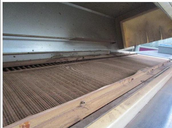
Inkijk krimptunnel. Geen gebreken waargenomen.
