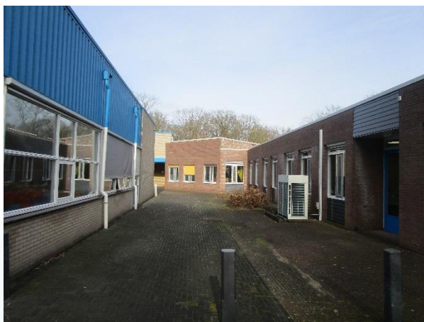
Links gebouw 4, rechts gebouw 3.
