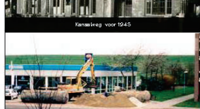
Kanaalweg bij garage Zandvliet, uitgraven van tanks
