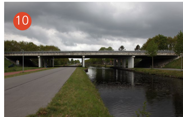
Viaduct A28 Drenthse HoofdvaartKloosterveen
