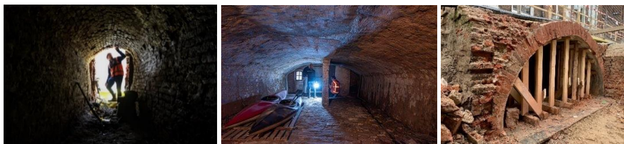
Figuur 7 - een kleine versus een grote kelder en kelder met ondersteuningsconstructie
