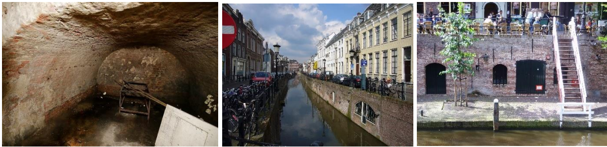
Figuur 1 - blinde muur straatkelder (foto Ruud Voest), kluismuur en werfmuur (foto Wikipedia)
