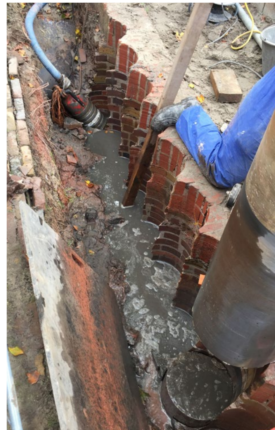
Een walmuur wordt hersteld door middel van de 'buispaalmethode' (foto: Gemeente Utrecht)
