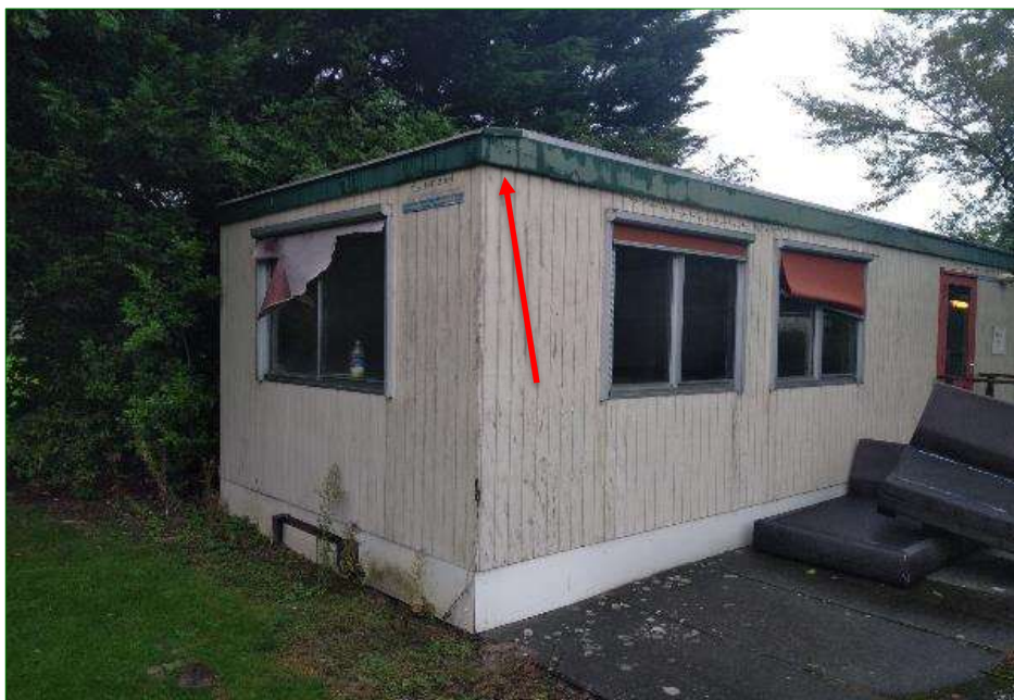
De locatie van het tweede gevonden paarverblijf (rode pijl) bevindt zich achter de dakrand van de keet.
