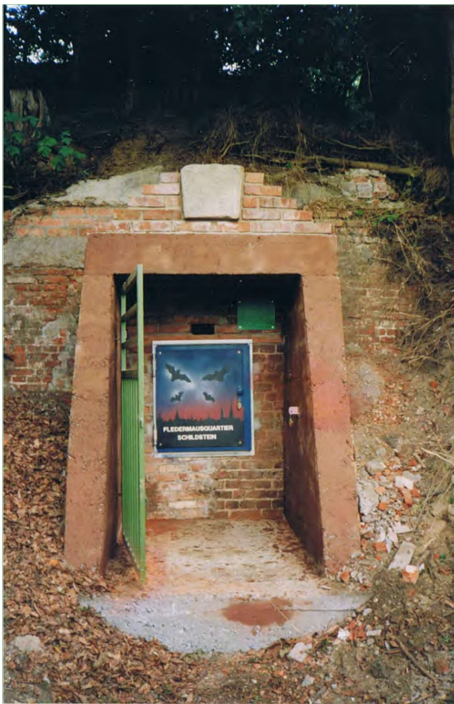
Voorbeeld van een dichtgemetselde hoofdingang met inspectieluik en traliewerk. Bron: SCHULZ & SCHULZ, 2012.
