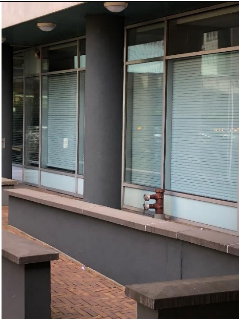
Hydrant voorzijde langs hoogbouw
